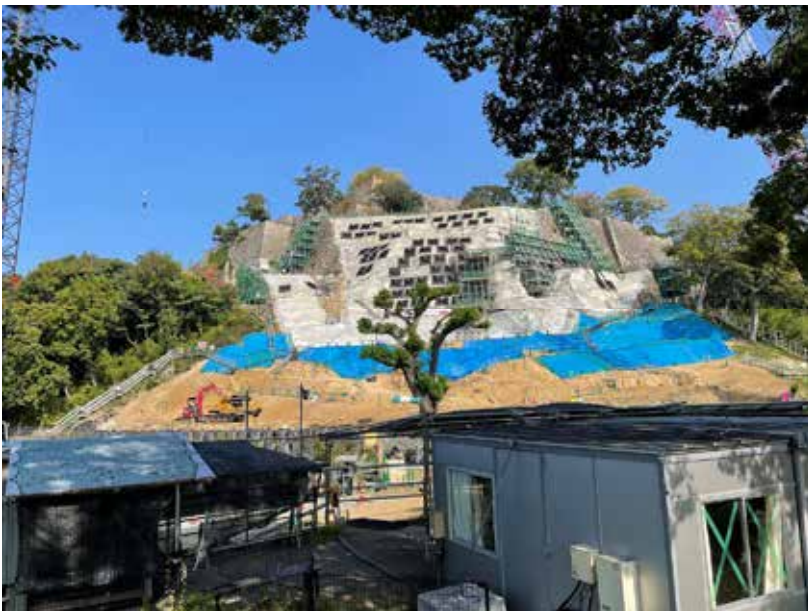
写真－４： 2022年11月時点での 石垣復旧工事の状況。
