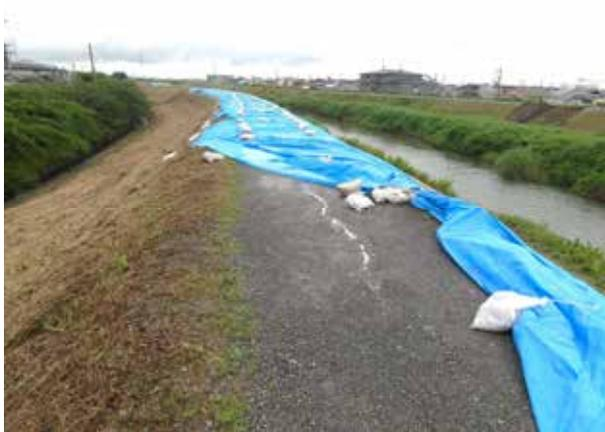
写真-1：天端の亀裂の様子。
