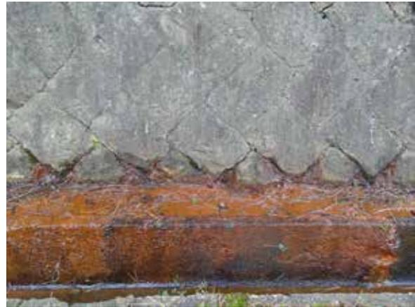
写真-6：斜面末端部において確認された湧水。
