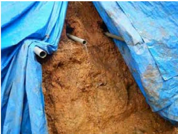
Bブロック：施工時の排水状況
