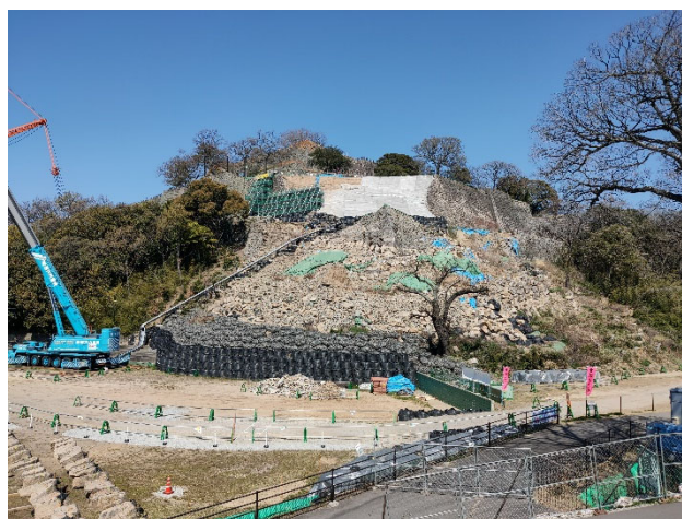
崩壊後修復中の南西の石垣
