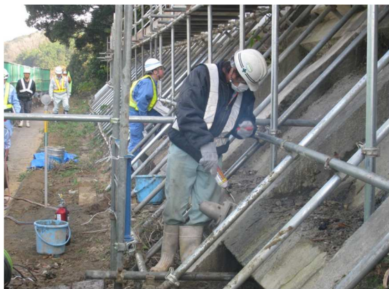
(b) 旧タイプアンカーの緊張力の除荷作業
