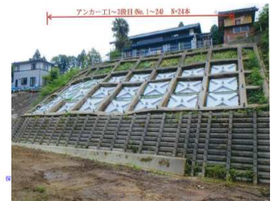
○既設を残したまま、深い震度までアンカーを増設
