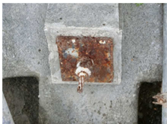
(b) 1 本より線のくさび定着方式のアンカー
