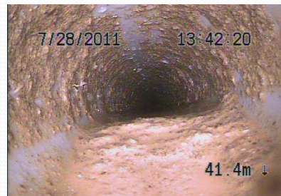
①洗浄前孔内状況
