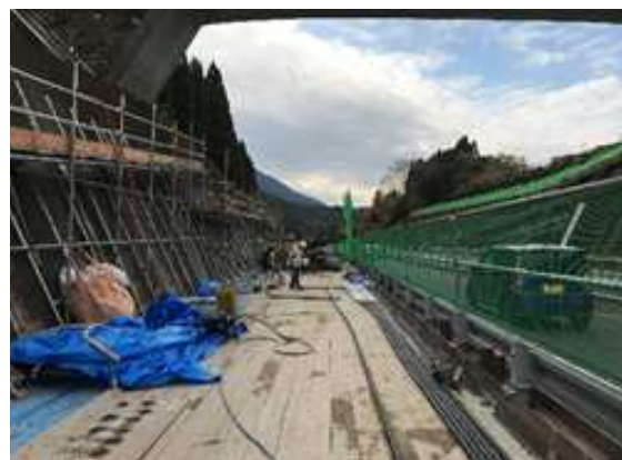
図-8 供用中区間での工事状況
