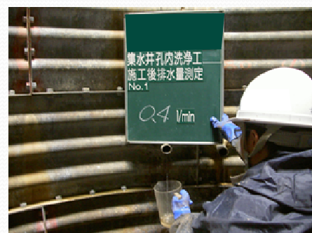
④施工後排水量測定
