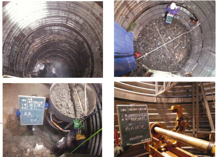
○詰石、静水層再設置、排水ボーリングの再設置
