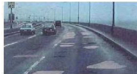
【有料橋の床版補修】
