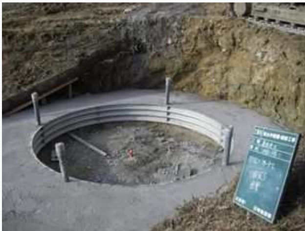
土砂による埋戻し
