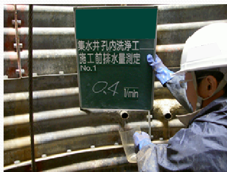
①施工前排水量測定
