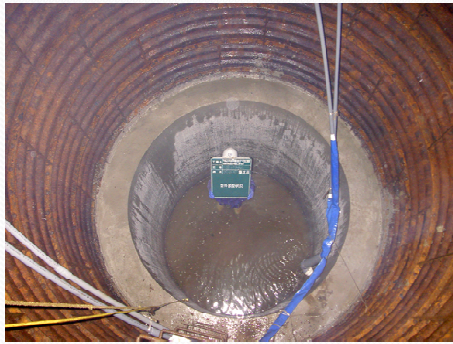
底盤コンクリート打設
