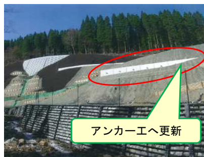
○アンカー工へ更新、杭工の頭部処理
