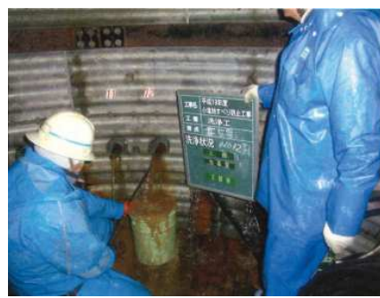
○集水ボーリングの孔内洗浄
