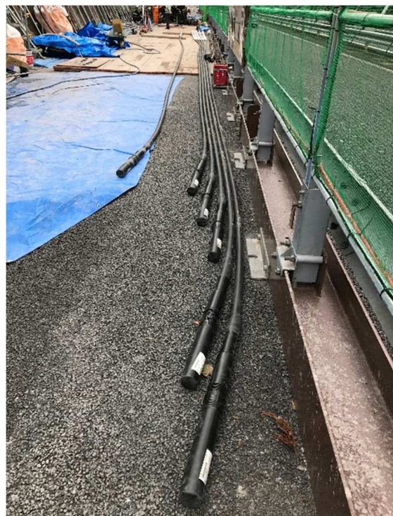
図-7 増し打ちする新タイプアンカー
