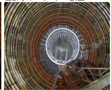
○集水井の改修、大口径排水ボーリングの設置
