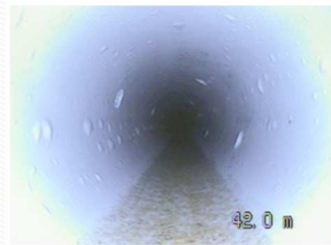
②洗浄後孔内状況
