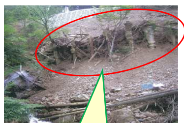
既設杭頭の露出
