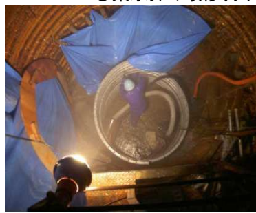
○集水井の改修、大口径排水ボーリングの設置
