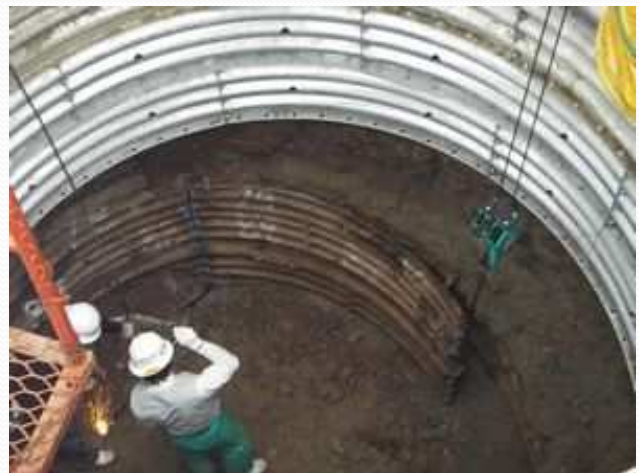
再掘削（旧ライナー取り外し）
