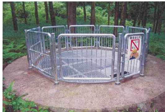
○耐雪型防護柵に交換
