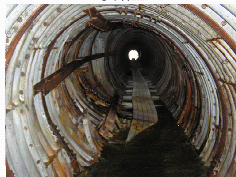
排水トンネル
