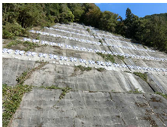
図-13 施工完了後の状況
