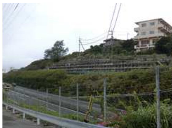
(a) 施工状況
