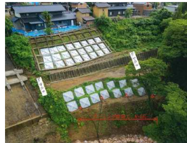
○既設を残したまま、深い震度までアンカーを増設
