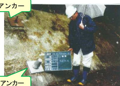
○アンカー工の再設置
