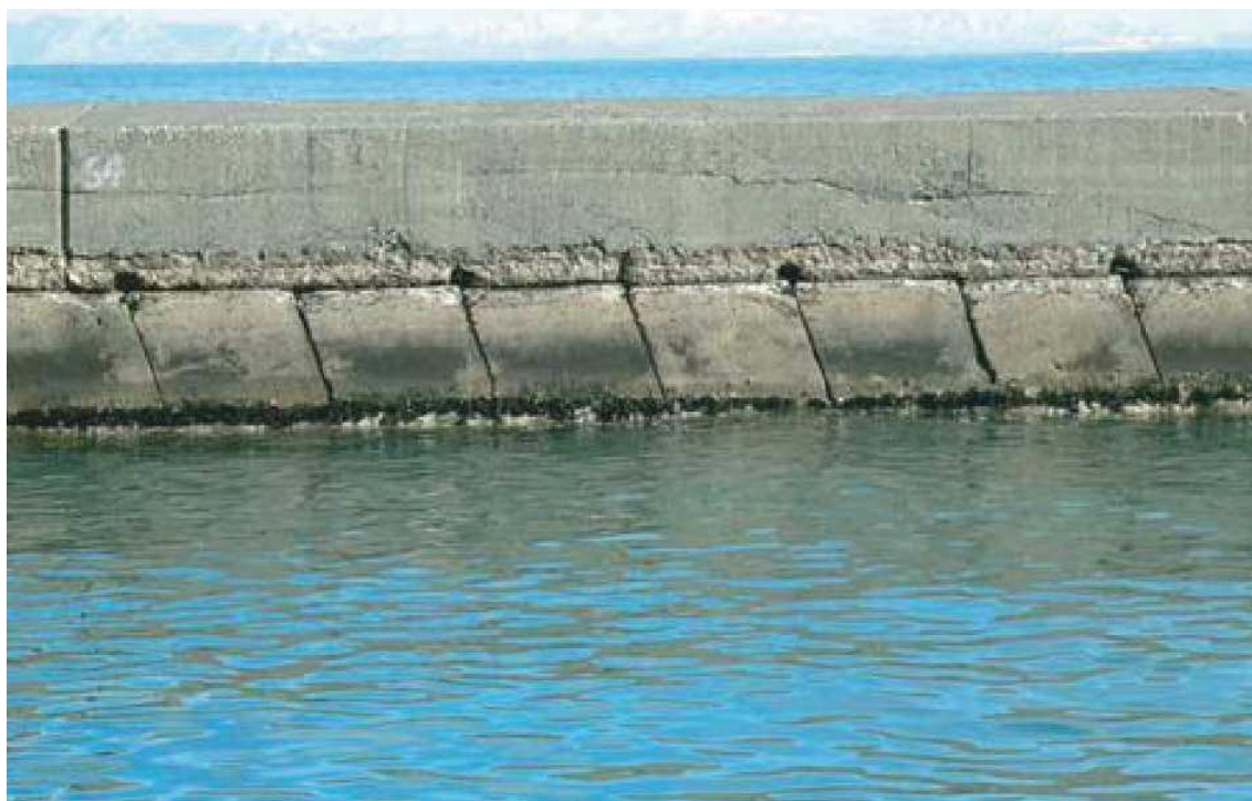
[現在も活躍する北防波堤の斜塊部]
