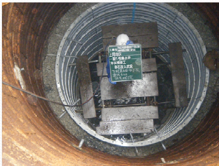
碎石詰め、パイプ接続
