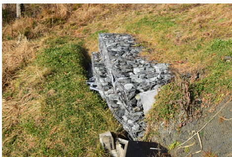
水抜きボーリング
