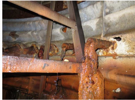
集水管目詰まり（鉄バクテリア）
