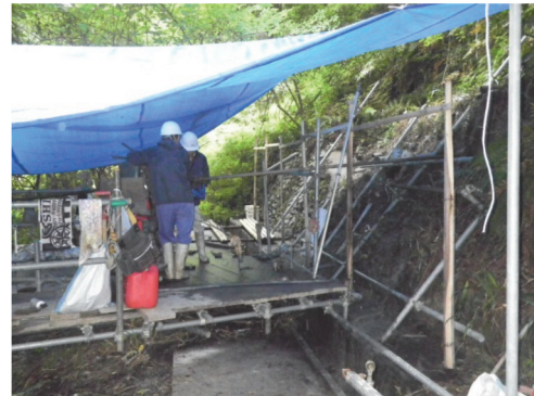
図一 1 3 応急対策工施工状況
