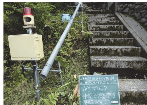
図－10 地盤伸縮計の設置状況
