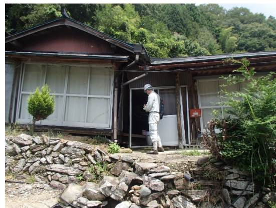
写真-12 左側部 被災した民家
