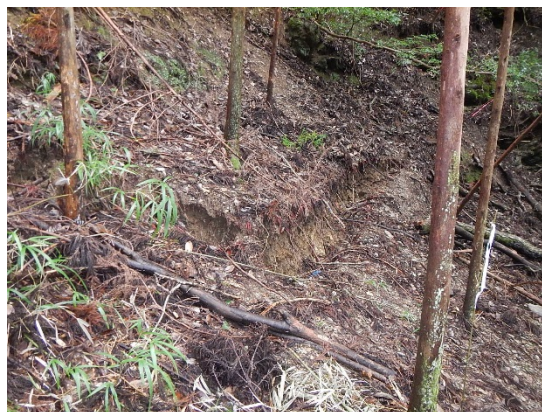
写真-10 斜面中央部の段差亀裂
