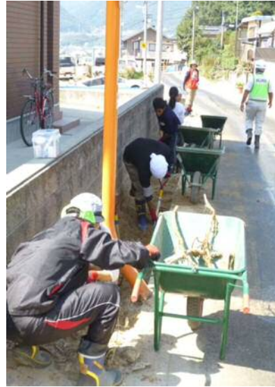
図-12 ボランティアの土出し作業
