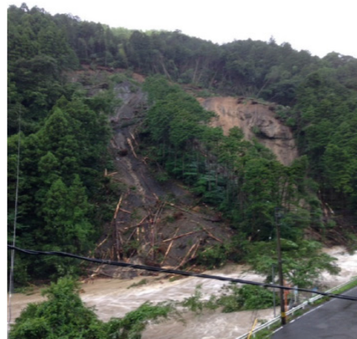
写真-1 崩壊地全景
