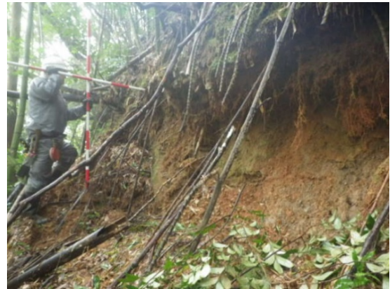
写真-3 崩壊地上部の滑落崖
