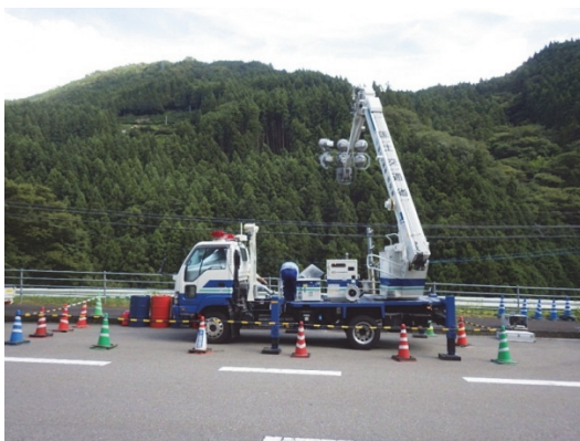
図－12 照明車・衛星通信装置による斜面監視
