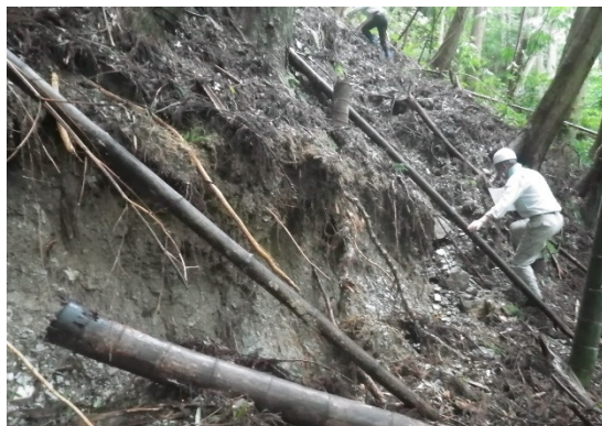
写真-14 ブロック頭部滑落崖
