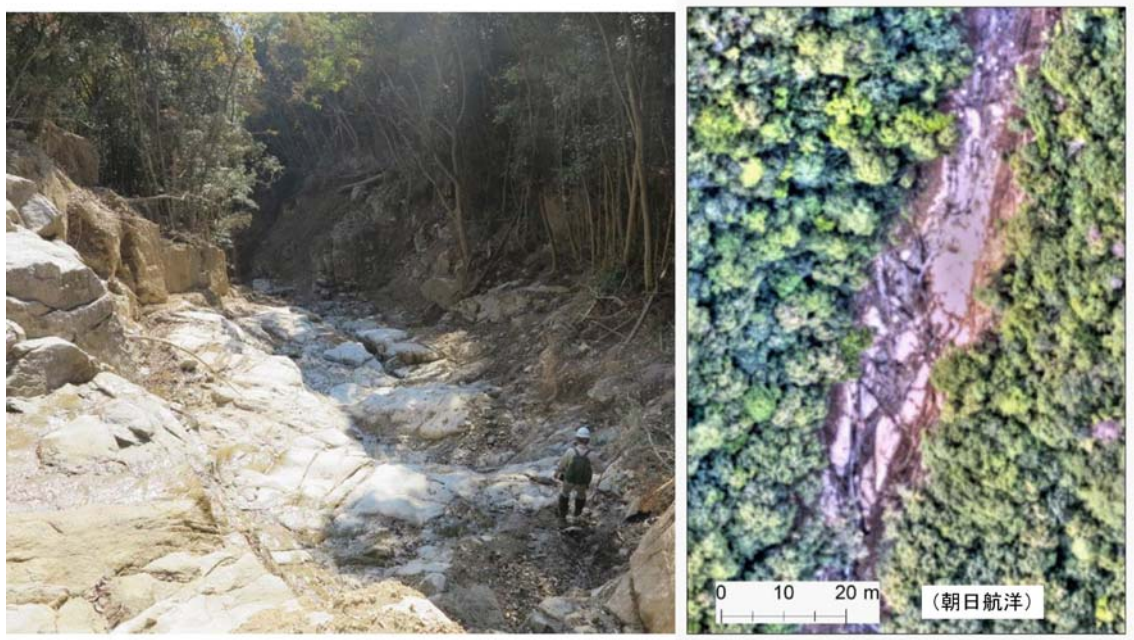
図 5 八木三丁目上方の沢の状況。左：現地地表写真。右：空中写真。谷の中がさらわれて平面的な岩盤面が露出している。これは、図 4 に示したように、緩んだ岩盤が取り去られたためである。
