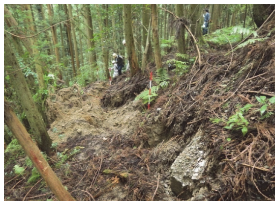
図－5 高知県大豊町怒田 地すべり頭部段差
