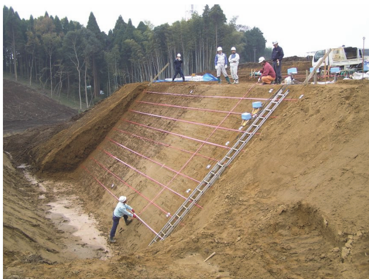
図-11 完成した試験盛土
