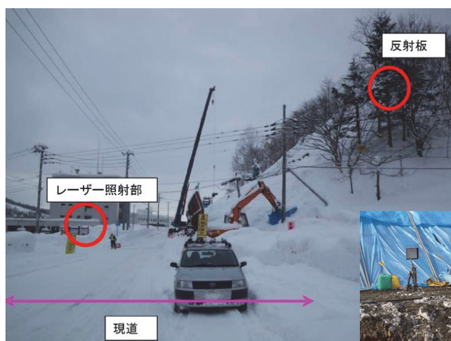
写真-7 拡散レーザ変位計計測斜面全景
