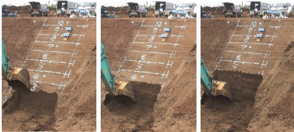
図-12 斜面の切取り（7段階まで段階的に掘削）
