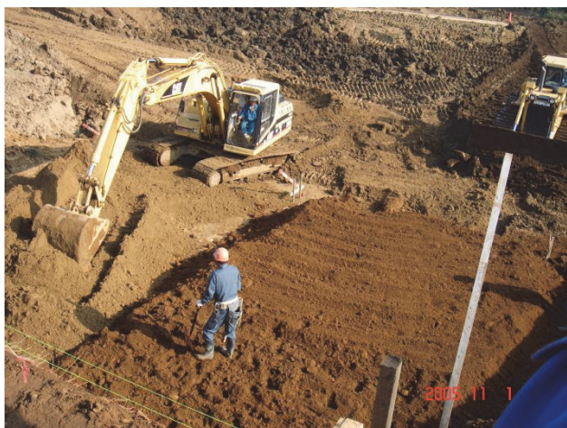
図-9 試料の投入・均し
