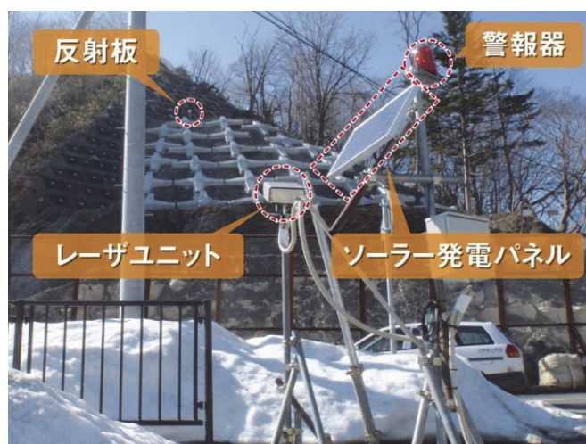
写真-6 拡散レーザ変位計設置状況
