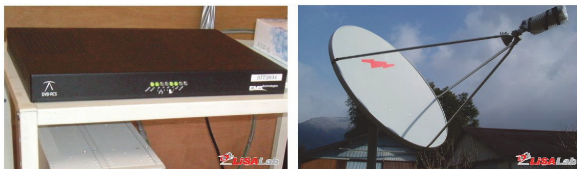
写真-3.5 衛星回線のルーターとパラボラアンテナ
