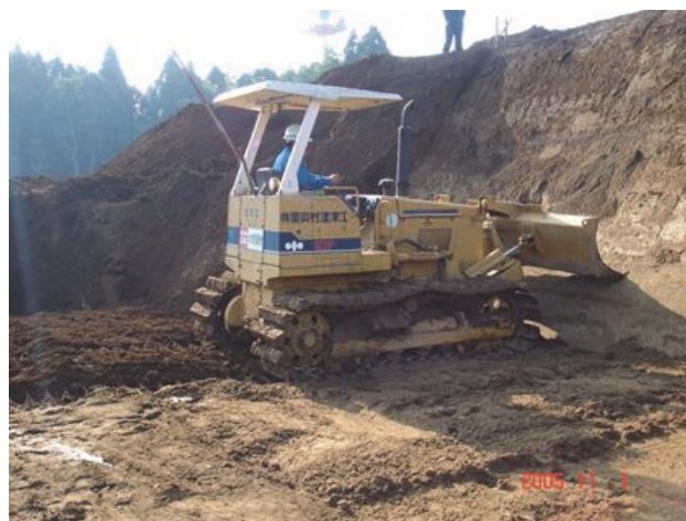
図-10 転圧に利用した湿地用ブルドーザー
