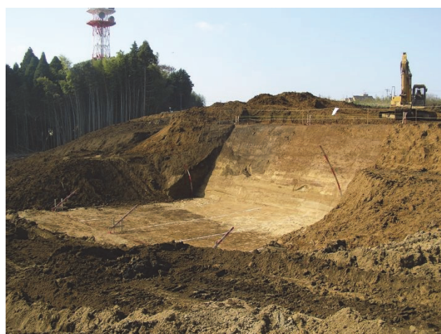
図-8 地山の切土掘削完了後
