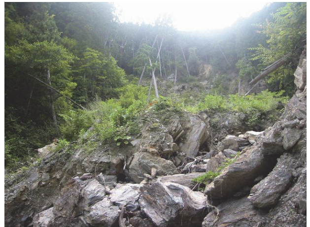
(a) 上部斜面の崩壊状況
