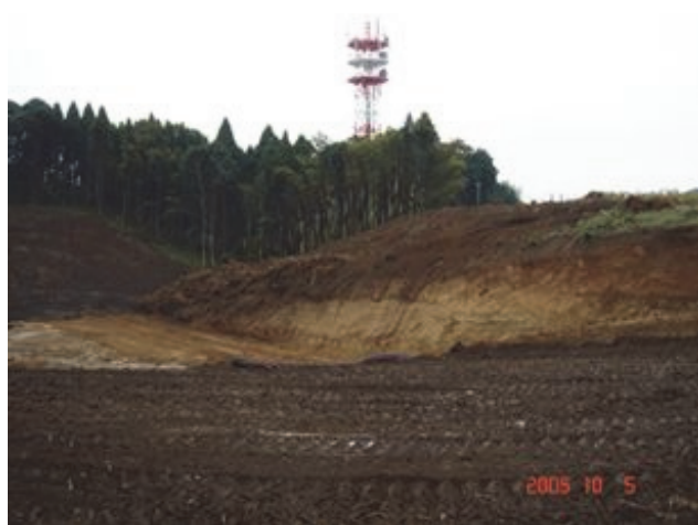
図-7 実物大実験現場（実験前）
