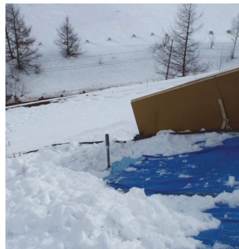
写真-10 Area net 傾斜計設置状況
