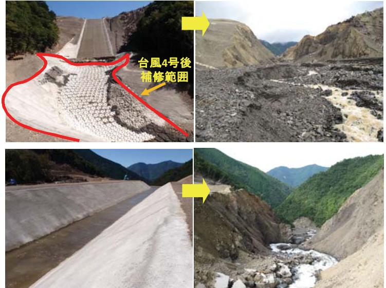
写真-12 栗平地区の被災状況（上；斜面部 下；水平部）
