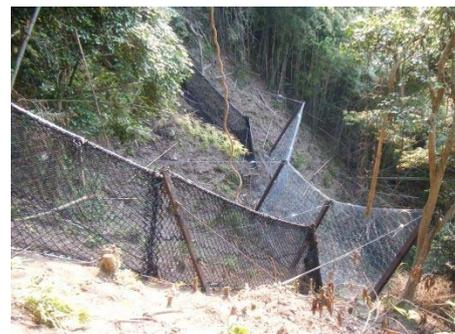
写真-9 高エネルギー吸収タイプの落石防護柵工
