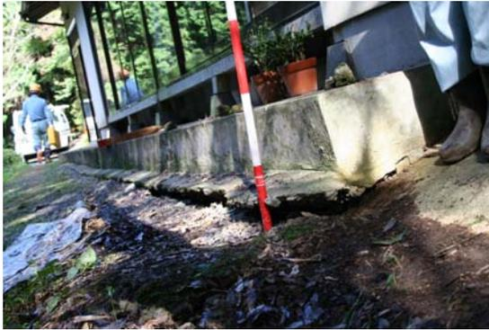
写真10 家屋基礎（犬走り）の沈下
