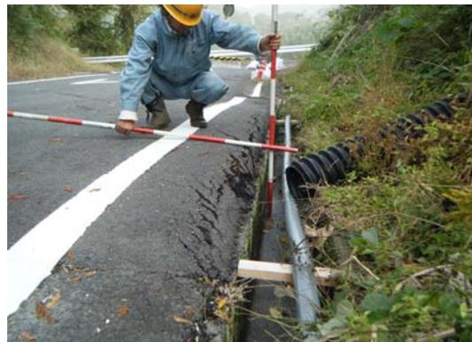
写真5 押し出し・隆起(パイプは仮設水道管)
