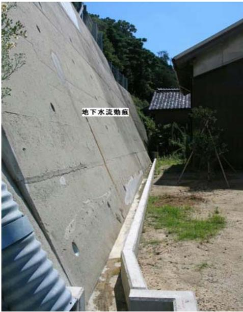
写真-9 擁壁に残る地下水流動痕
