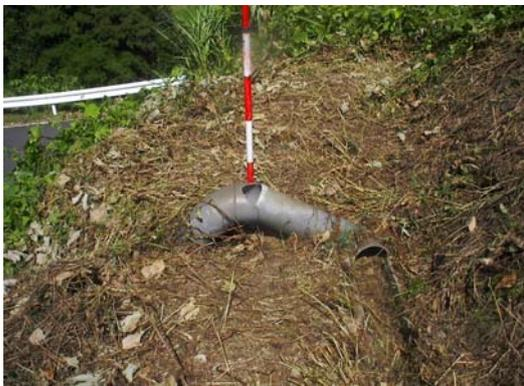
写真4 排水パイプの変形
