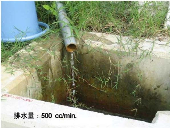
写真-14. 崩壊斜面・擁壁背面の排水
