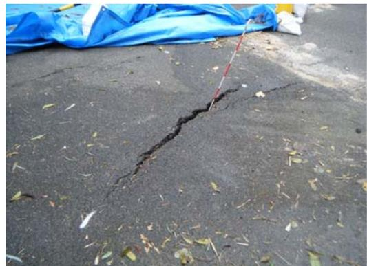
写真9 路面の段差・クラック
