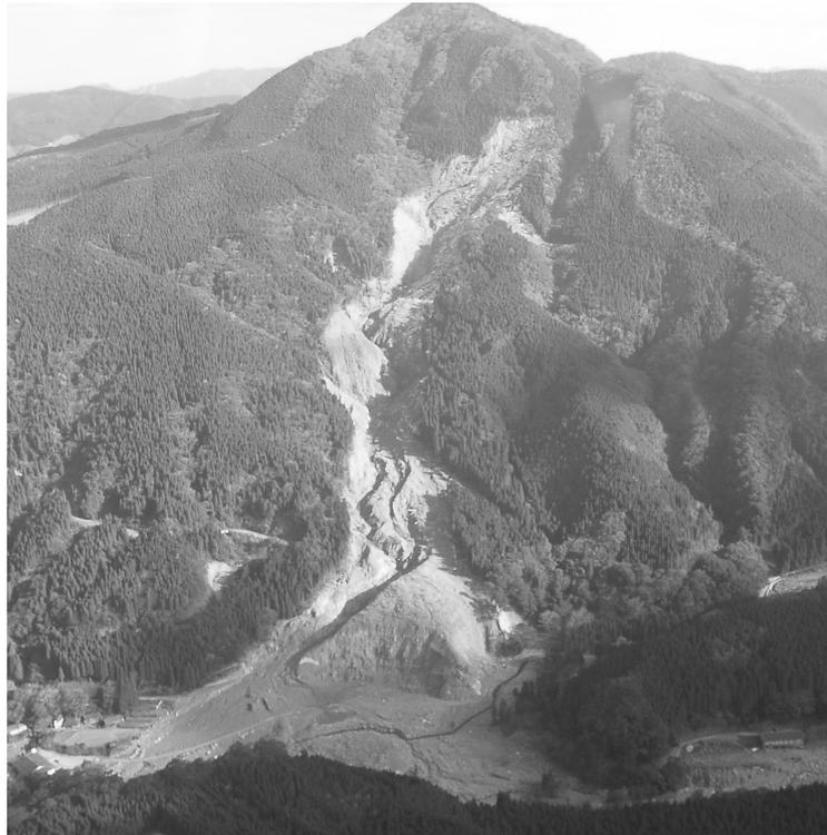
図－4 鱈塚山の深層崩壊と土石流(2005年12月22日撮影)
