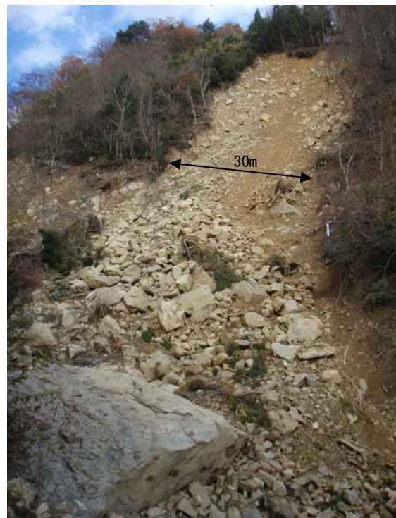
図-1 切土中の斜面崩壊
