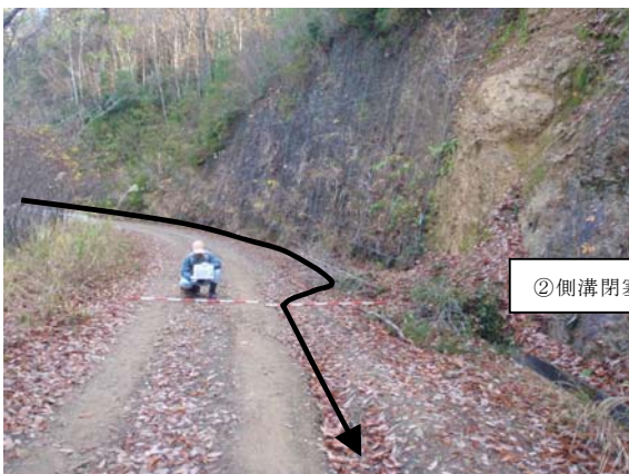
図-3 林道の排水機能不能による災害例
