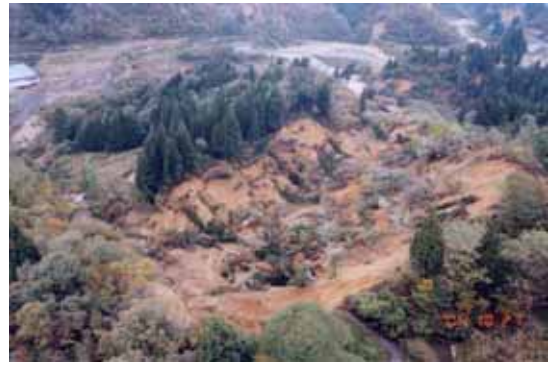
写真-2 東竹沢地すべり頭部の滑落崖
