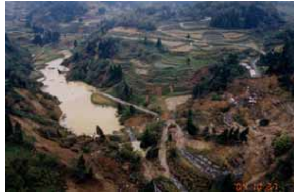
写真-10 寺野地すべり
