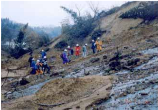
写真-9 主滑落崖で観察されたすべり面
