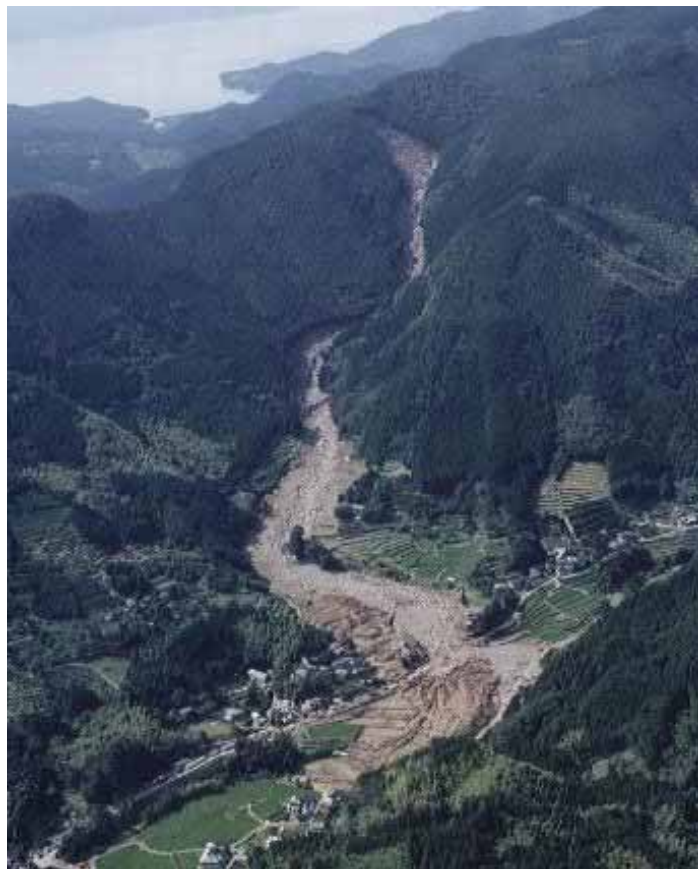
写真-1 集川土石流の状況（アジア航測(株)撮影）
