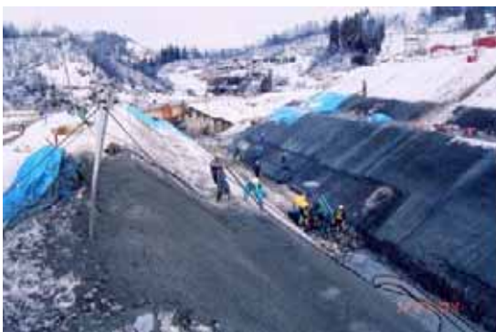
写真-7 仮排水路施工状況
