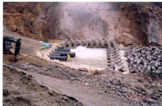
写真-6 埋設管路による代替排水路
