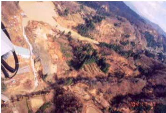
写真-5 ポンプによる緊急排水中の異常侵食
