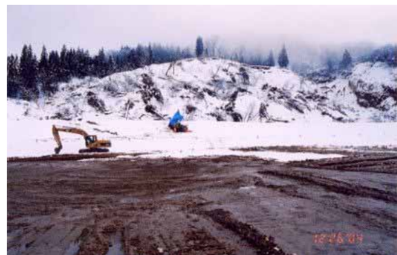
写真-8 東竹沢地すべり頭部排土工
