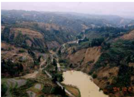
写真-11 寺野地すべり（左岸側が地すべり）
