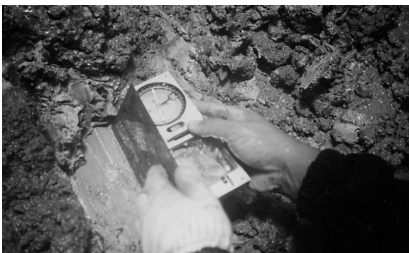
図-1 新第三系(凝灰岩)堆積岩地すべりのすべり面状況
