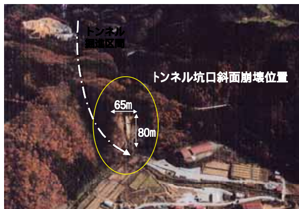
図— 1 4 坑口の崩壊の様子
