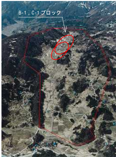
地すべり地全景
