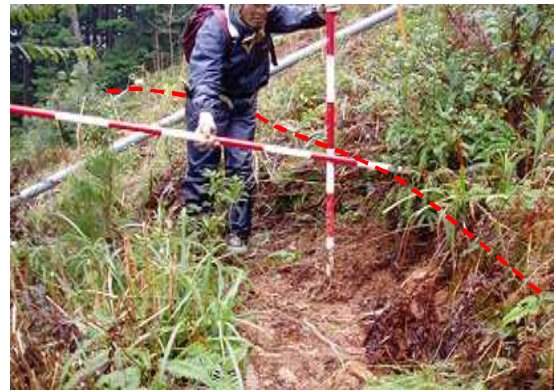
滑落崖の状況
