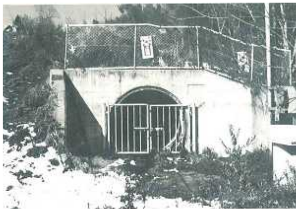
1号排水トンネル工
