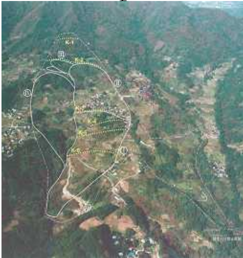
地すべり全景
