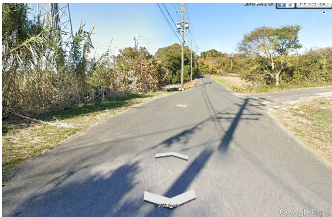
①地すべり地頭部の農道の状況（現在工事中）
