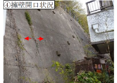
④擁壁開口状況
