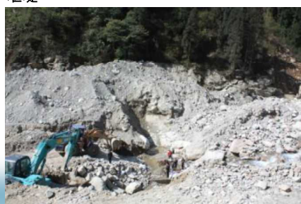
龍池鎮龍溪河の堰堤設置の床掘
