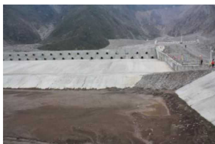
清平郷文家沟の崩壊地内に設置された砂防堰堤
