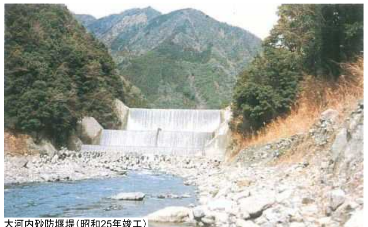
大河内砂防堰堤(昭和25年竣工)
