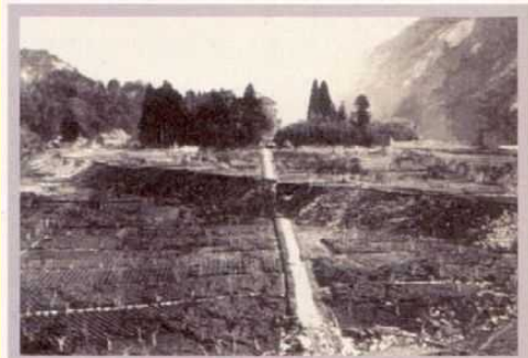
根尾谷断層 1891年(明治24年)濃尾地震(M8.0)の地震断層 (写真 小藤文次郎1893年より)
