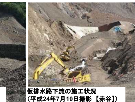
出水により仮排水路に一部土砂が堆積 (平成24年7月10日撮影【赤谷】)
