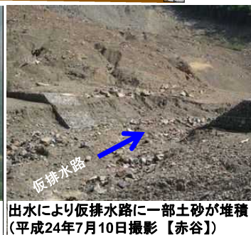
仮排水路下流の施工状況 (平成24年7月10日撮影【赤谷】)
