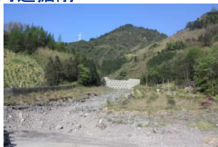
龍池鎮麻柳沟に設置された砂防堰堤(水抜きが多い)
