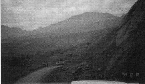
崩壊後約3箇月後(1999年12月15日)
