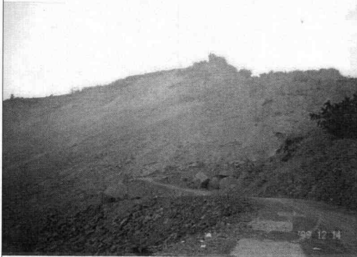
崩壊後約3箇月後 (1999年12月14日)
