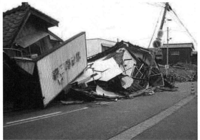
1階部分は完全に倒壊している
