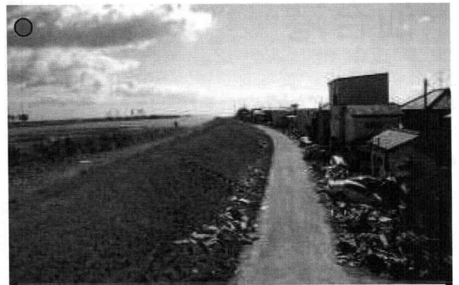
堤防に被害なし(津波は堤防を乗り越えていない)
