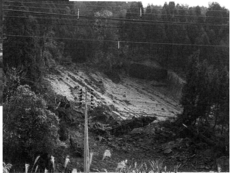
すべり落ちた岩盤が 国道を塞いだ(横渡)
