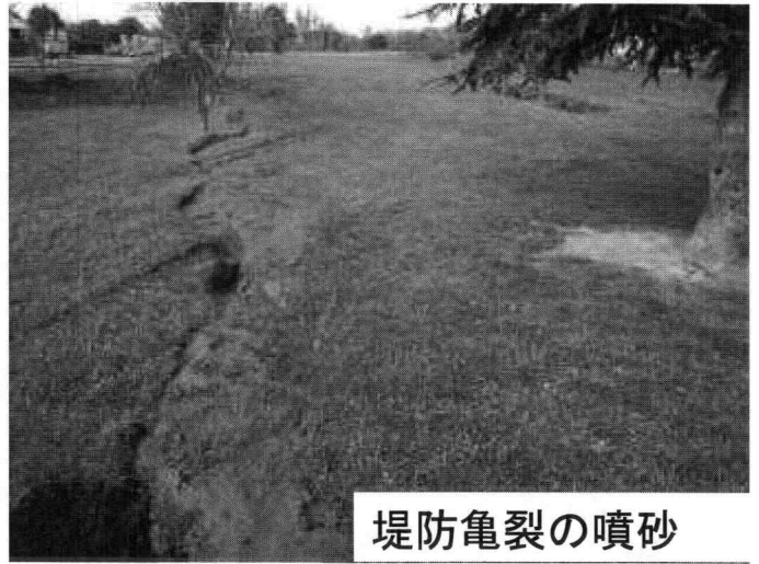
堤防の亀裂(堤内側)
