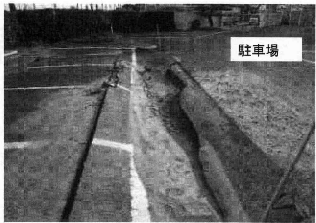
埋設管理戻土の液状化による陥没
