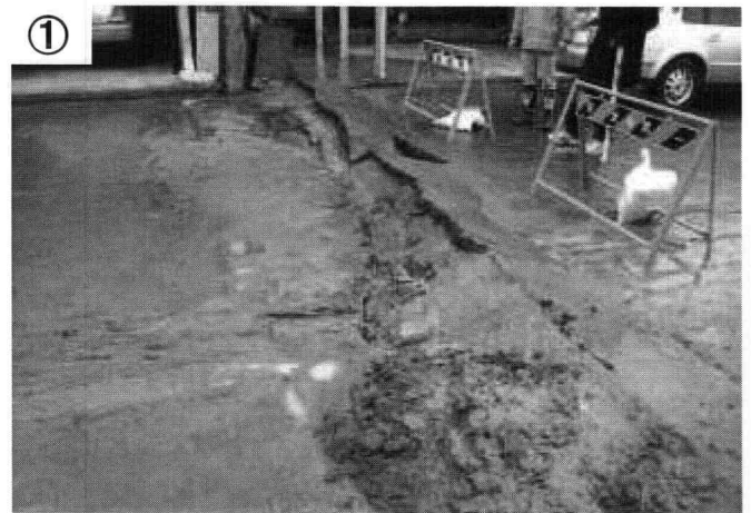
① 旧河道上もしくはその境で道路のずれや大規模な噴砂が発生
