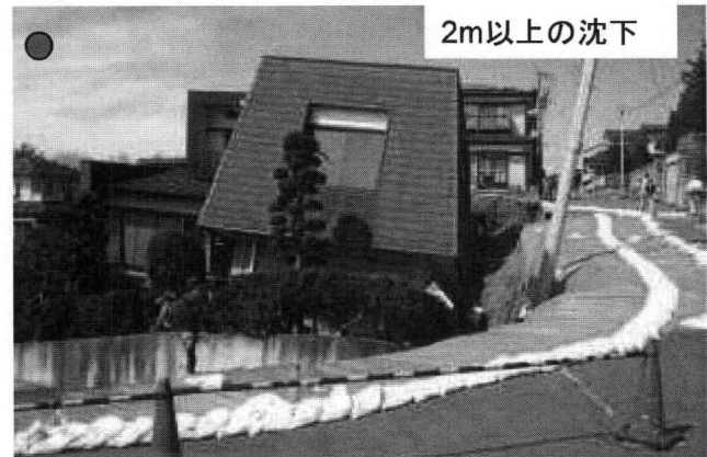
南側の崩壊. 下部への土砂流動は大きくないが上部では数m沈下
