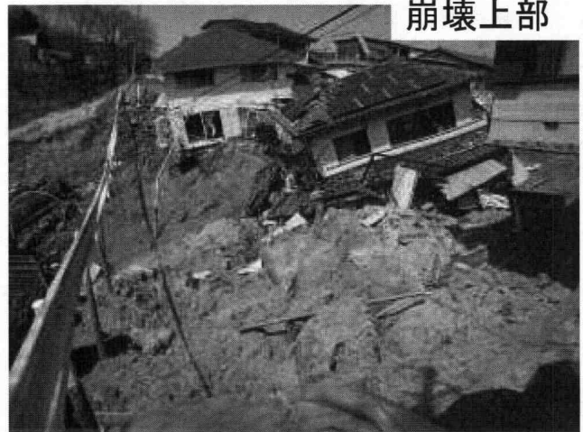
南側の崩壊. 下部への土砂流動は大きくないが上部では数m沈下
