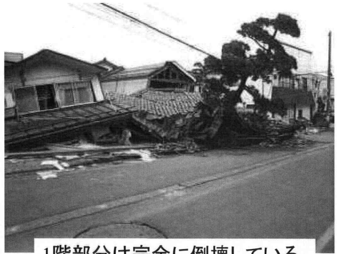
1階部分は完全に倒壊している
