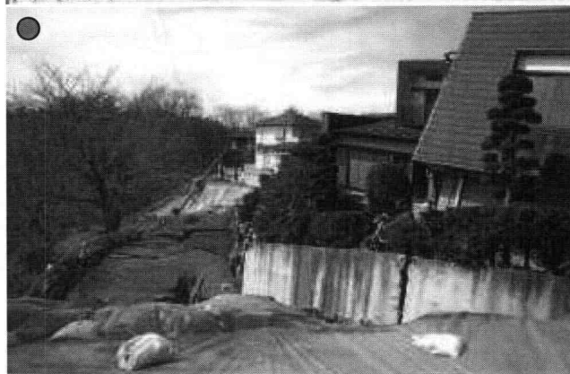
南側の崩壊. 下部への土砂流動は大きくないが上部では数m沈下
