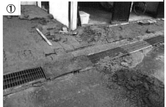
① 旧河道上もしくはその境で道路のずれや大規模な噴砂が発生
