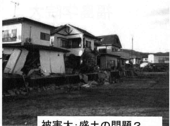
液状化による塀と外灯の傾き
