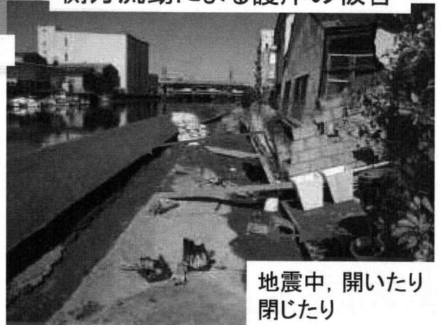
側方流動による護岸の被害
