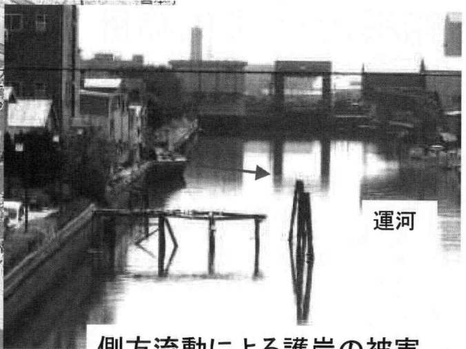
側方流動による護岸の被害
