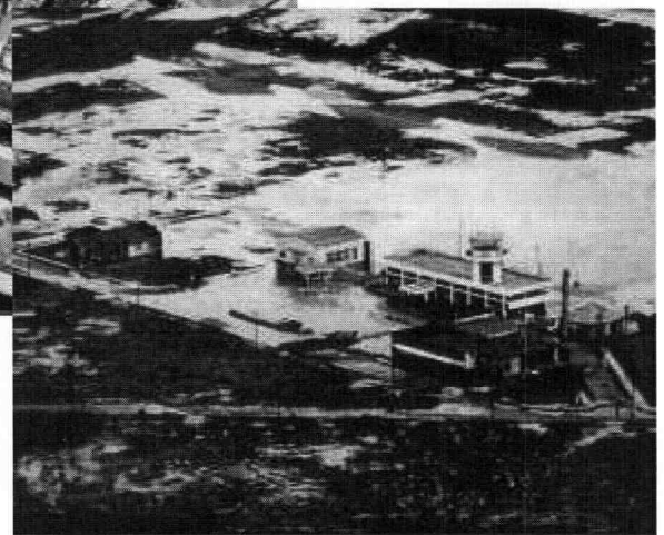
新潟空港の 液状化
