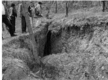
中央部ブロック頭部の陥没帯
