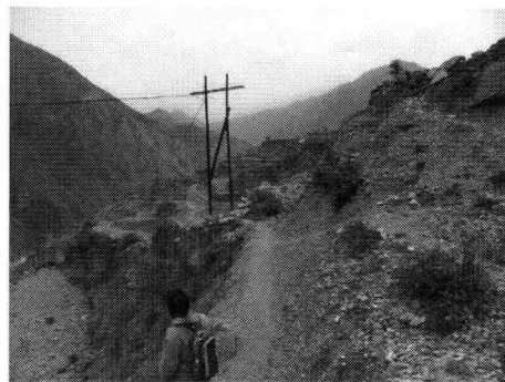
末端部付近の状況 (下流側)
