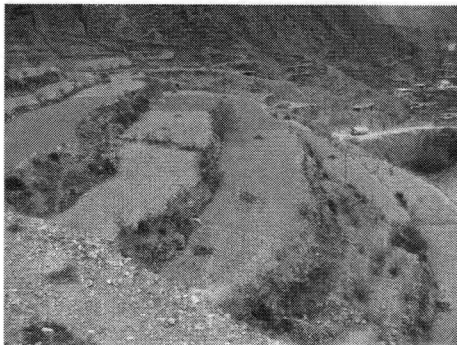
末端部付近の状況 (上流側)
