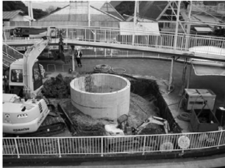
地すべり頭部の遊園地内 での集水井実施
