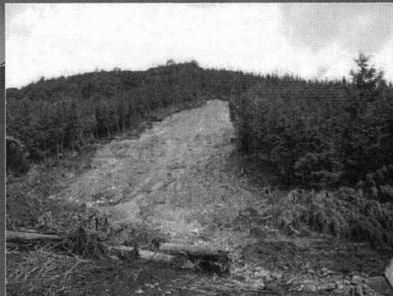
典型的な崩壊箇所
