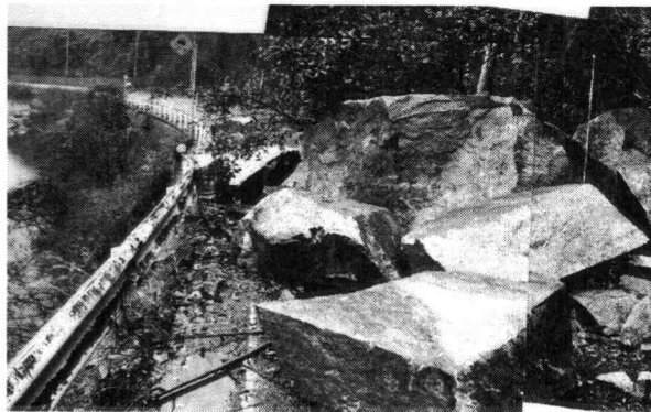
図3.1 国道432号を閉塞した落石群（芸予地震，2001年3月）
