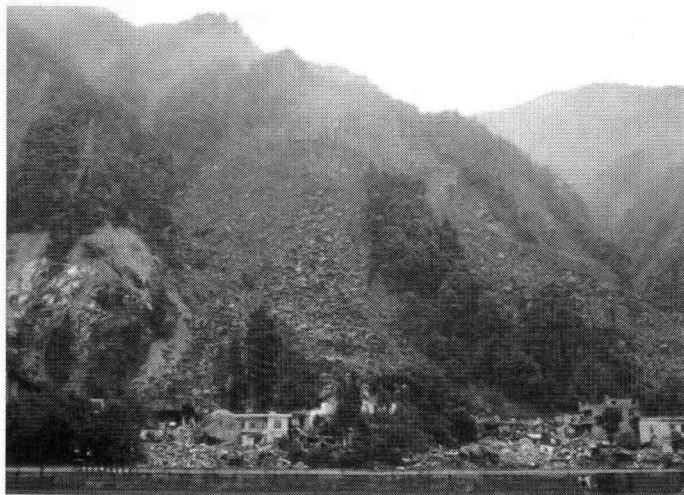
図3.11 汶川県映秀における岷江の左岸側の斜面崩壊と建物破壊（2008 年8 月2 日撮影）
