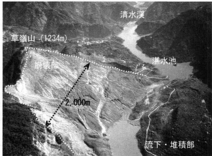
図 3.9 草嶺山崩壊地の全景（河道閉塞による上流湛水池のほか、流下・堆積地内にはオーバーフローによる湛水池ができた。2000 年 12 月 17 日撮影）
