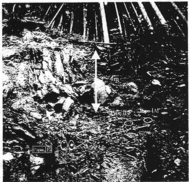
図-3 C支溪の右岸崩壊地源頭部の状況
