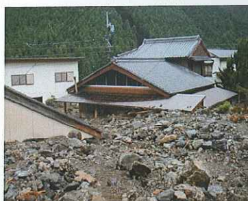
久豆・宮の谷の土石流
