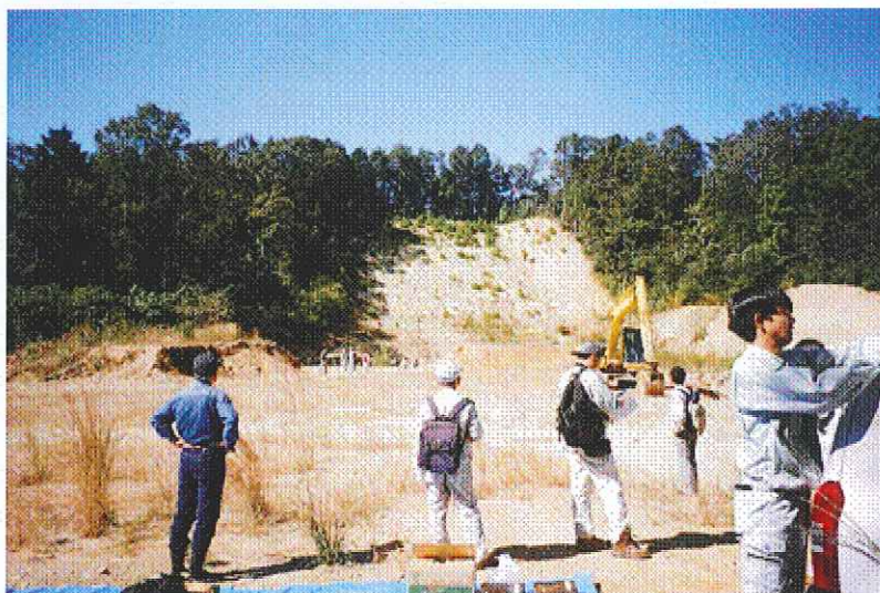
写真-1 頭部排土工の見学
