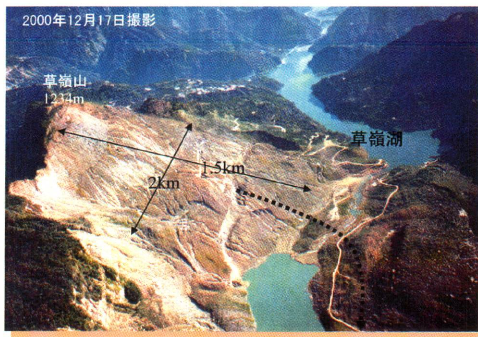
写真-5, 6 草嶺山の地すべり性崩壊状況 (2000 年 12 月 17 日撮影)
