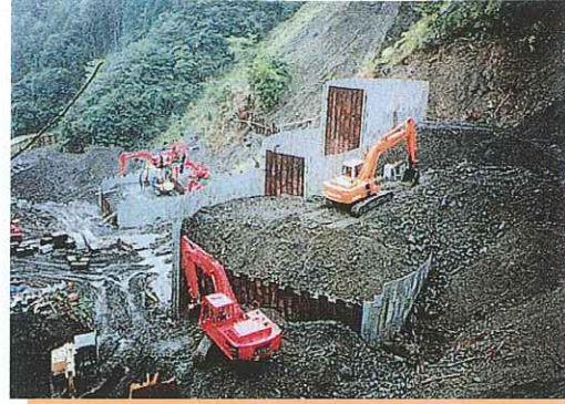
鋼製砂防ダム施工中
