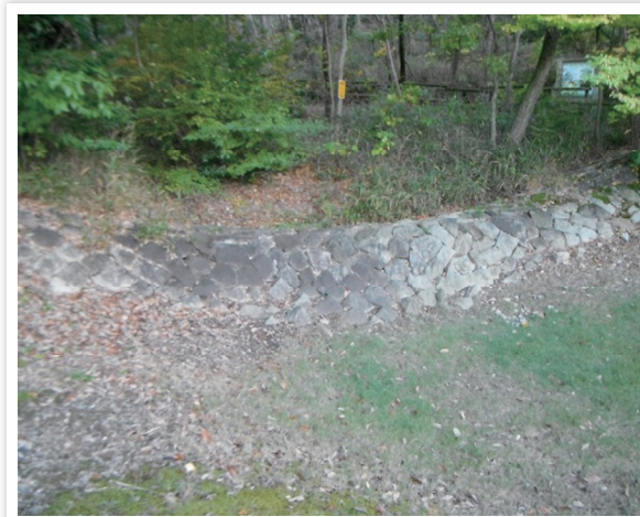
萩御殿 ハゲ山対策事業 石堰堤
