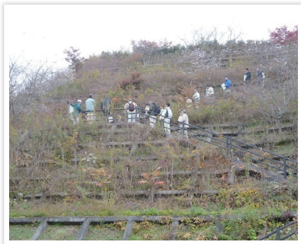
堂ノ本地区 急傾斜地対策事業
