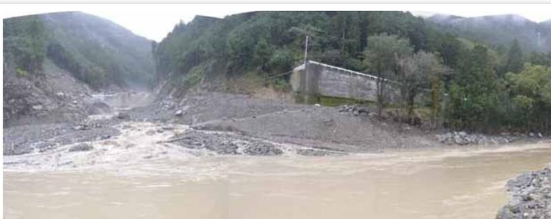
岩井地区（宮川との合流点）写真左が岩井の支流。写真中央で道路が途切れているように見えるのは、土石流により支流を横断していた橋梁が破壊されたためである。
