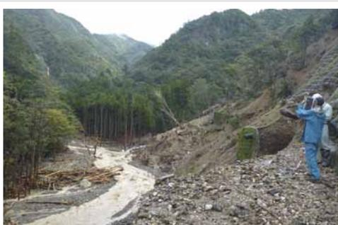
東又谷の土石流、流木と山腹崩壊による道路崩壊
