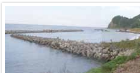
海中に施工された土砂流出防止工
