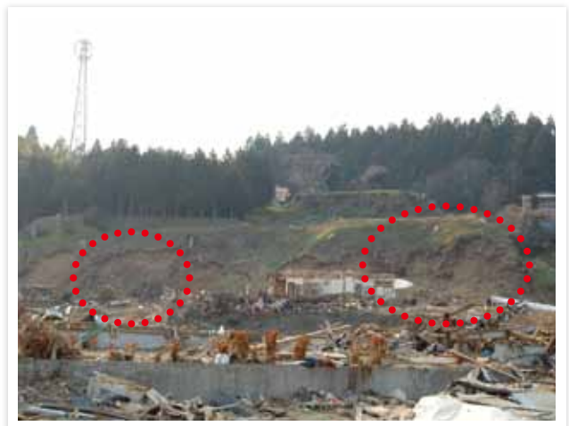
津波遡上による斜面浸食（気仙沼市） 未対策斜面に津波の遡上の影響で斜面崩壊が発生
