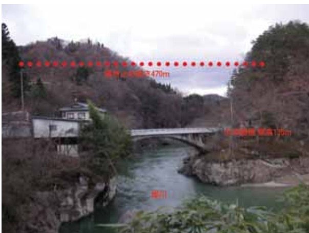
上流の久米路橋を下流から望む／湛水面の高さ（標高470～480mと推定）からすると、久米路橋は水没し、木橋だったため、浮き上がって上流に流れ着いた。写真右の立岩は頭部が水没しなかった。
