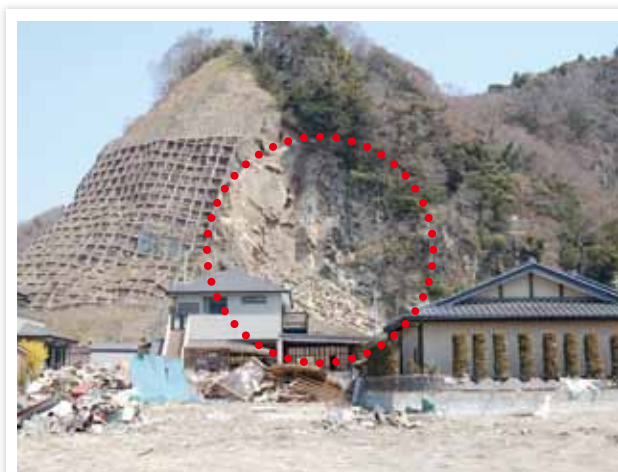
地震動による斜面災害（石巻市） 急傾斜地崩壊防止施設の未対策斜面において、保全対象付近で土砂崩落が発生
