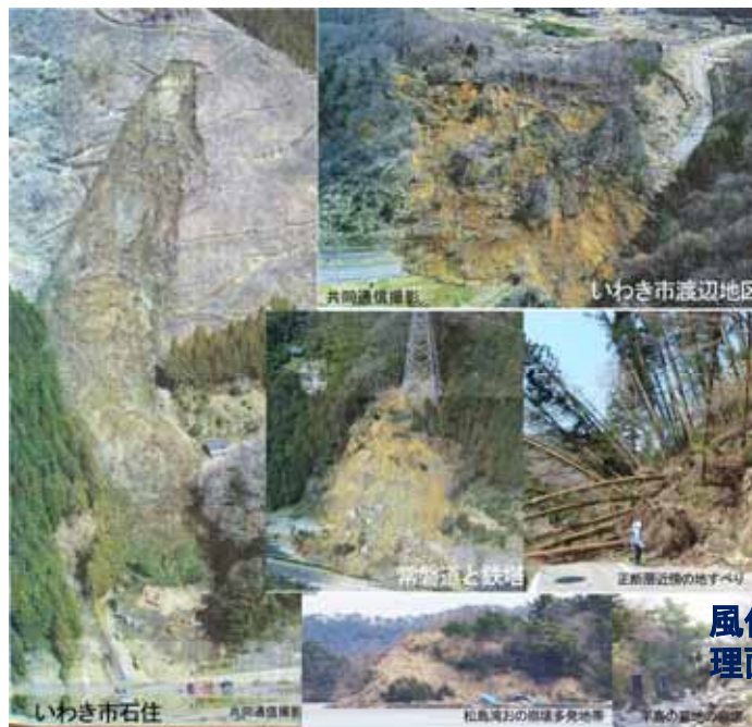
いわき市で発生 した余震による 崩壊・地すべり、 松島湾周辺の 岩盤崩落(本震) (宮城豊彦氏提供)
