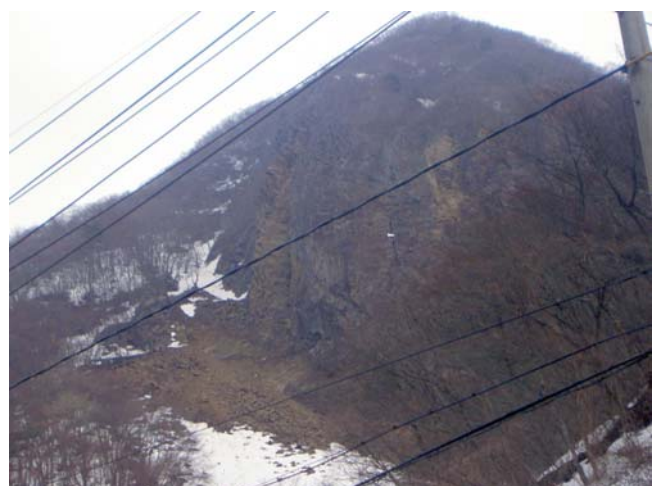
写真-4 鳴子ダム左岸のノーシェッド上部に 発生した岩盤崩壊
