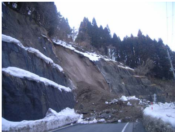
写真 3 斜面崩壊の様子
