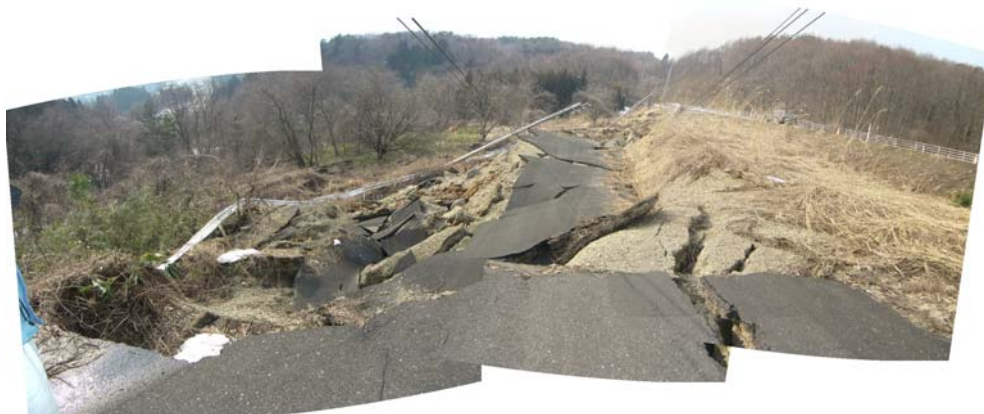
写真 7 地すべりブロック中間部の状況
