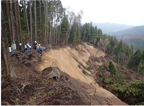
写真 5.2.6 天笠山東斜面で発生した拡大性の地すべり性崩壊（位置は図 5.2.2 の③）
