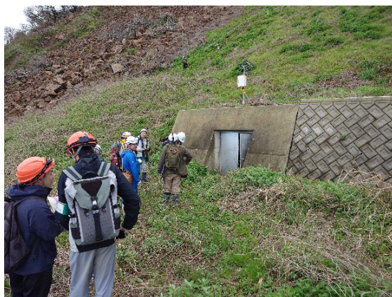
写真 5.3.13 排水トンネル坑口 変形は明瞭ではなく、扉の開閉は可能である。
