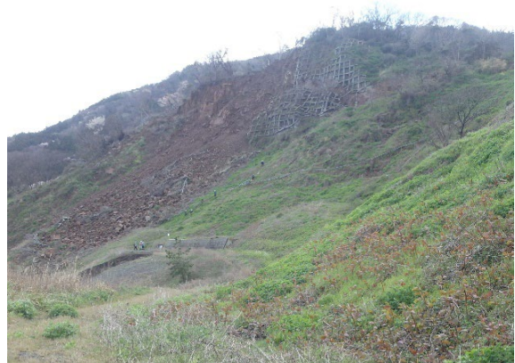
写真 5.3.12 滑落崖全景 吹付法砕工が破断し、東側（写真左側）は崩壊が発生している。
