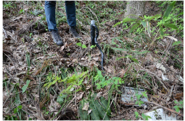
写真 5.1.3 地すべり変動の観測の痕跡
