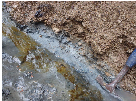
写真 5.3.24 すべり面の状況 灰色の凝灰質粘土が分布している。
