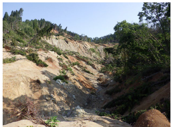
写真 5.3.10 地すべり全景
