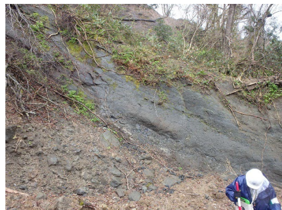
写真 5.3.22 側部露頭状況 シルト岩～礫岩の流れ盤構造が確認できる。層理面走向・傾斜 N50^{\circ}E/40^{\circ}N
