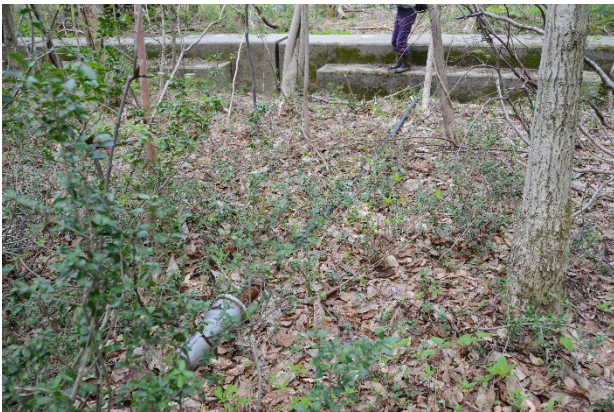
写真 5.1.2 抜け出したアンカー
