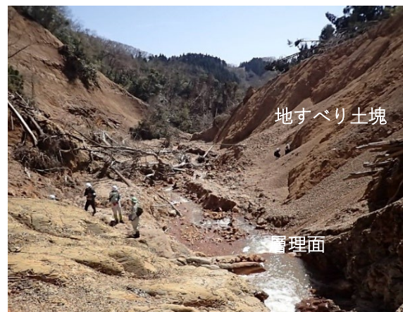
写真 5.2.2 牛尾川支流の右岸斜面から発生した地すべりで河道閉塞が発生した箇所（位置は図 5.2.1 の②）
