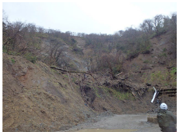
写真 5.3.20 中屋トンネル北側坑口 東側斜面全景
