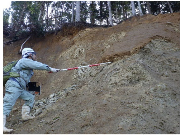
写真 5.3.6 西側側方崖斜面
