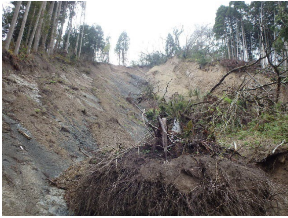
写真 5.3.23 周辺斜面の状況 層理面すべり（写真左側）が発生し、落ち残り土塊（写真右側）が確認できる。
