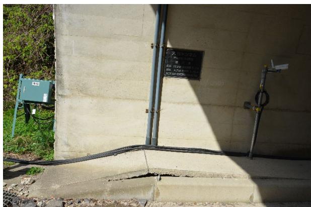
写真 5.1.24 坑口の変状
