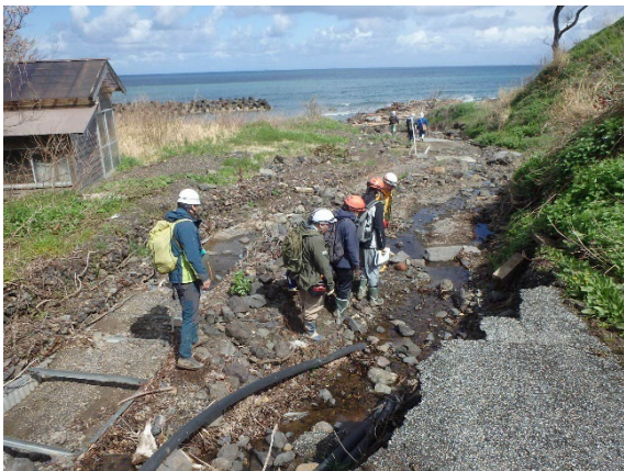
写真 5.3.11 農道被災 排水トンネルへ向かう農道は 9.21 豪雨災害により破損している。
