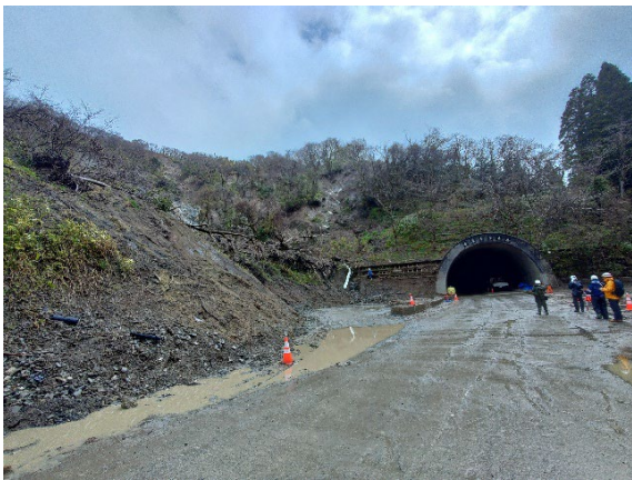
写真 5.3.19 中屋トンネル北側坑口 9.21 豪雨により大量の土砂が流入した。
