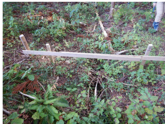
写真 5.3.22 尾根付近の亀裂
