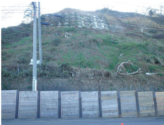
写真 5.3.7 既設アンカー工箇所全景
