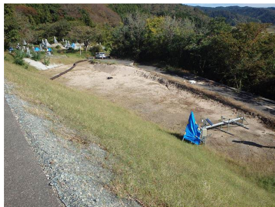
写真 5.3.16 応急頭部排土工の状況
