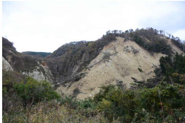
写真 4-1 仙谷川右岸の表層崩壊状況.
