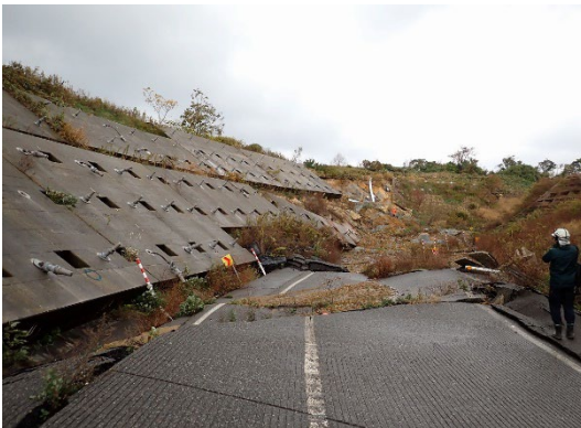
写真 2-2 抜け出しが生じたアンカーと断面状況
