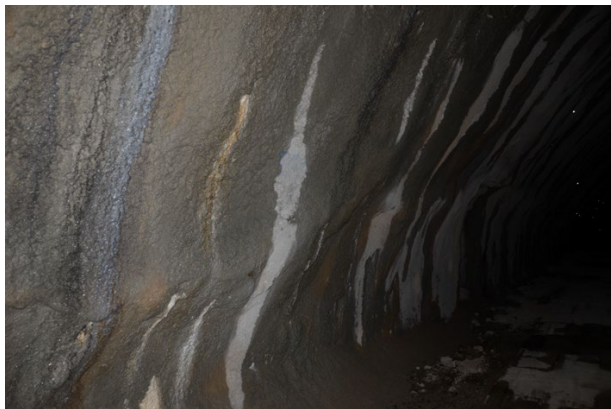
写真 1-2 変状が生じた支保工周辺のコンクリートを削った後に保護のための吹き付け状況
