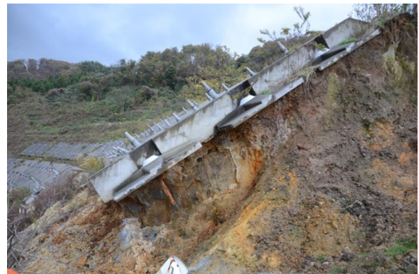
写真 2-2 抜け出しが生じたアンカーと断面状況
