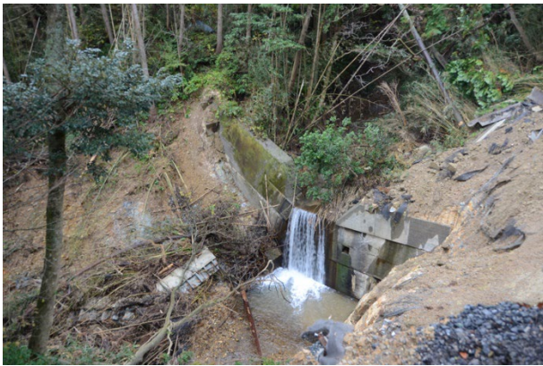
写真 2-1 土石流による侵食によって生じた崩壊
