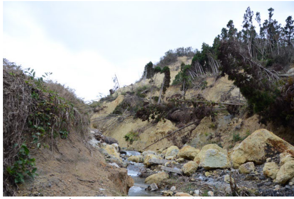
写真 4-3 清水地区の末端部状況
