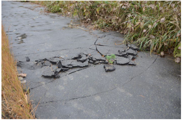
写真 2-3 地すべり全景 (左) と側部の亀裂 (右)
