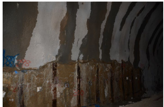
写真 1-2 変状が生じた支保工周辺のコンクリートを削った後に保護のための吹き付け状況
