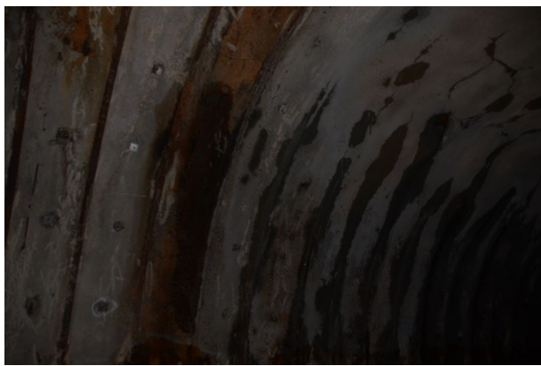
写真 1-1 変状が生じた支保工周辺状況
