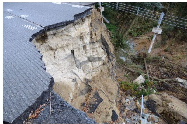
写真 2-1 土石流による侵食によって生じた崩壊
