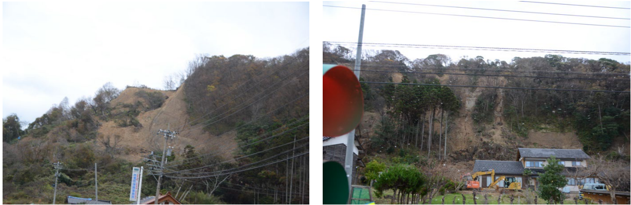
写真 3-1 珠洲市赤神地区の斜面災害状況
