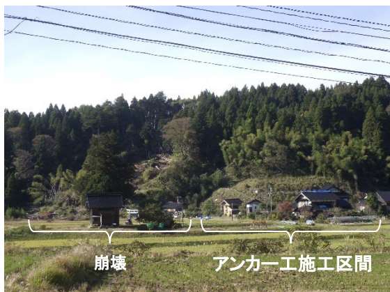
写真 5.3.19 地原地区全景
