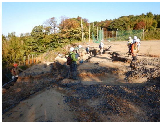
写真 5.3.14 段丘面にみられる地すべり による変状 ただしこの斜面は造成地の盛土である。
