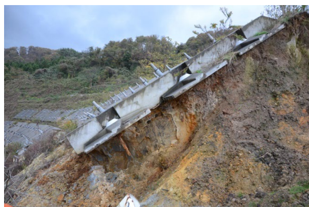
写真 5.1.5 抜け出しが生じたアンカーと断面状況
