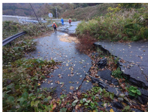
写真 5.1.6 地すべり頭部滑落崖（左）と側部の亀裂（右）
