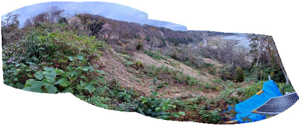
写真 5.1.8 斜面中腹状況
