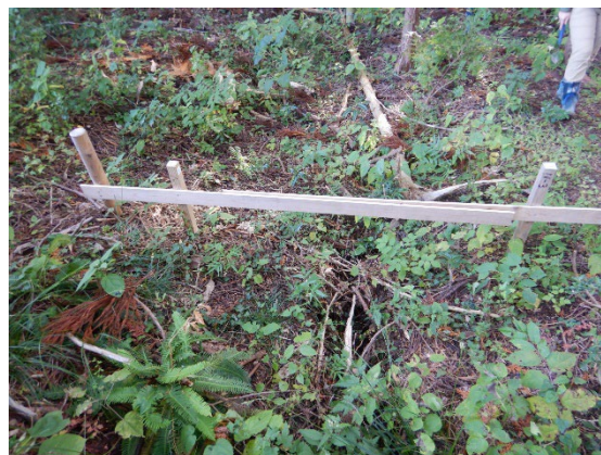
写真 5.3.22 尾根付近の亀裂
