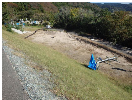
写真 5.3.16 応急頭部排土工の状況
