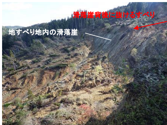
写真 5.3.2 地すべり地内の滑落崖 滑落崖背後には、尾根付近から滑落崖上部に抜けるすべりが生じている。
