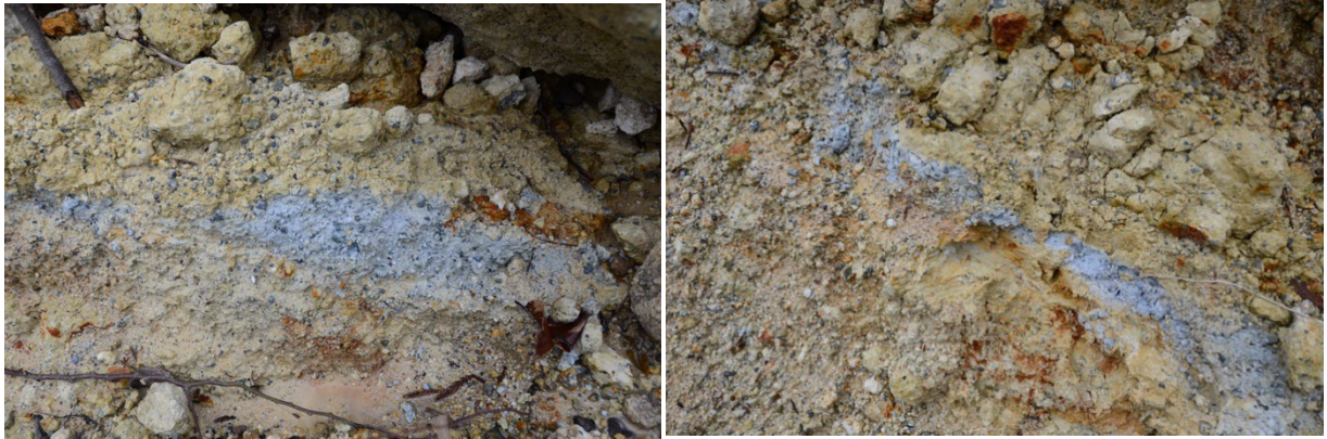
写真 5.1.12 地すべり末端部に露頭している地すべり粘土（写真 5.1.11 の上流部、左岸）
