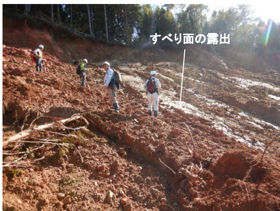
写真 5.3.3 地すべり頭部付近の状況 土塊流失により、すべり面が露出している。すべり層厚は下部に比べ浅い。
