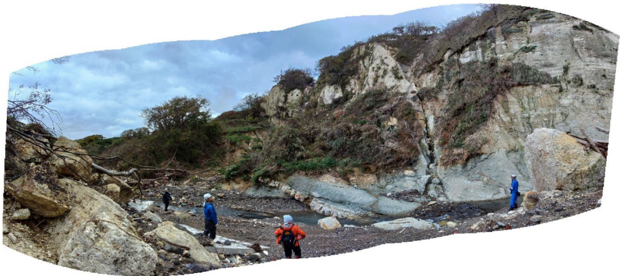
写真 5.1.13 断層と想定される箇所周辺状況
