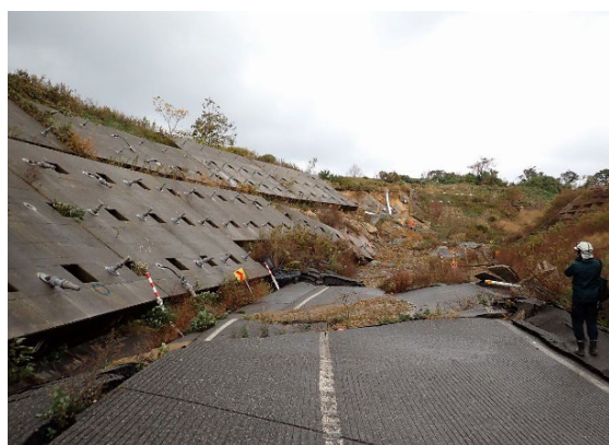
写真 5.1.5 抜け出しが生じたアンカーと断面状況
