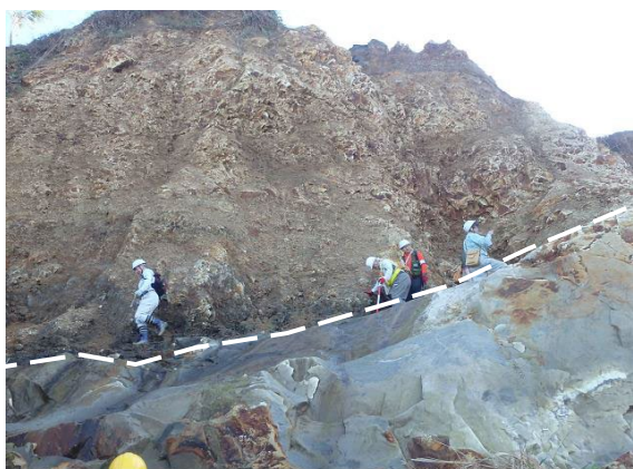
写真 5.3.11 すべり面の露出
