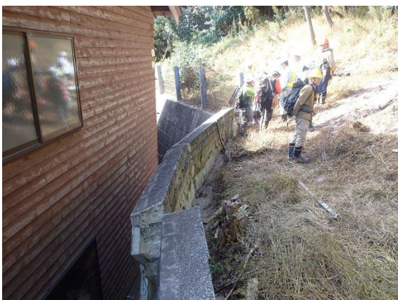
写真 5.3.17 地すべりによる変状
