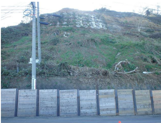
写真 5.3.7 既設アンカー工箇所全景
