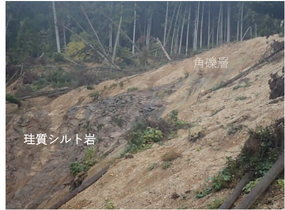
写真 5.2.7 地すべり土塊末端部に見られる角礫層とその下位の珩質シルト岩
