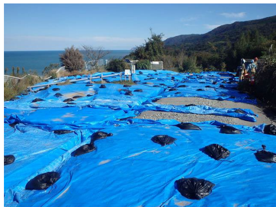
写真 5.3.10 地すべり頭部の状況 伸縮計による監視が行われている。
