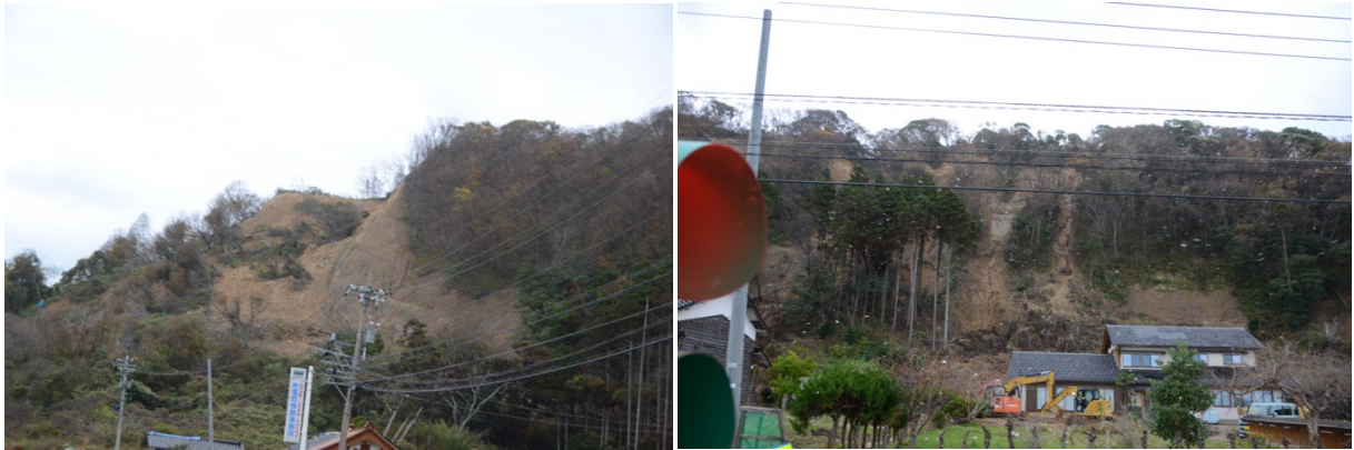
写真 5.1.7 斜面災害状況
