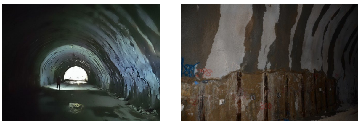
写真 5.1.2 変状が生じた支保工周辺のコンクリートを削った後に保護のための吹き付け状況
