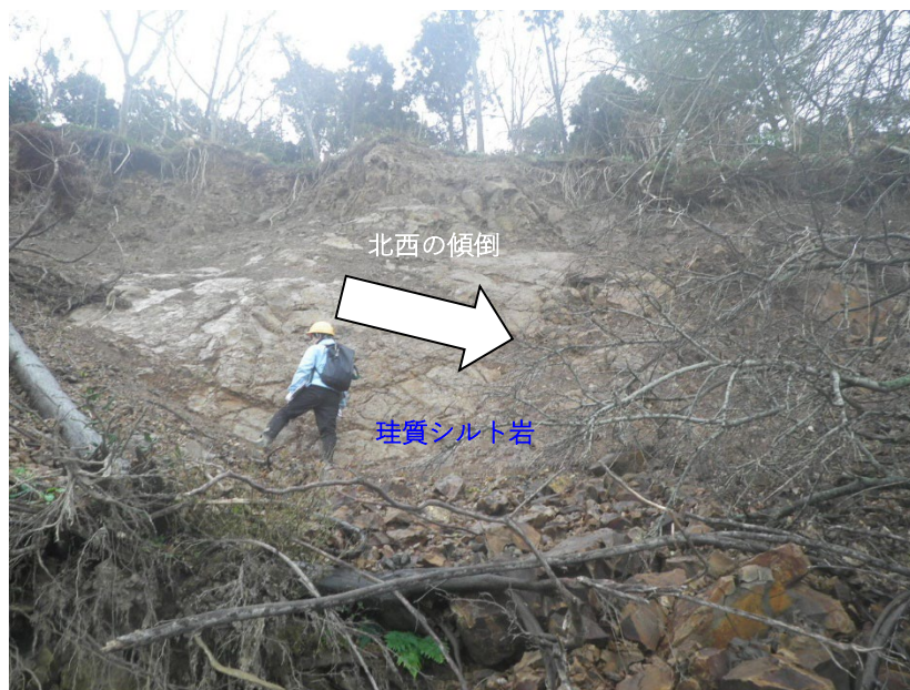
写真 5.2.4 側端の珪質シルトと地層の傾斜
