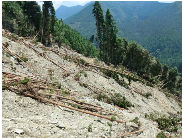
写真7 地点④より崩壊の対岸を見る
