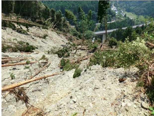
写真6 地点④よりみた崩壊下部
