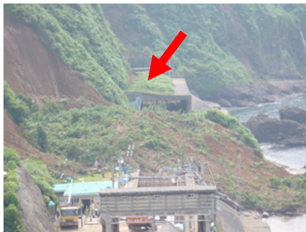
写真-2 柏崎市青海川地区。崩壊の奥、ロックシェッド上の古い堆積物とそれを覆う植生
