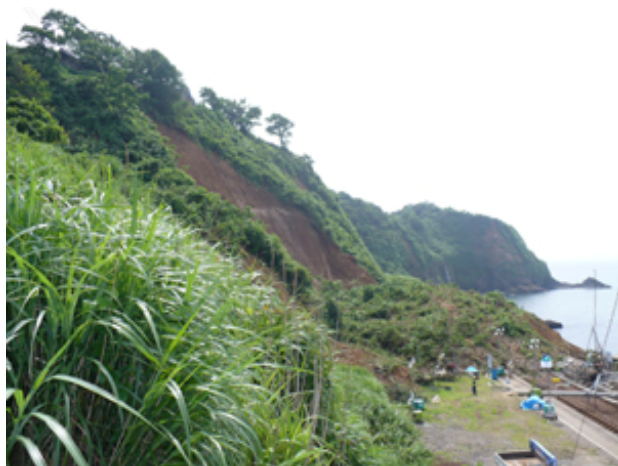
写真-1 柏崎市青海川地区。J R 青海川駅の斜面崩壊
