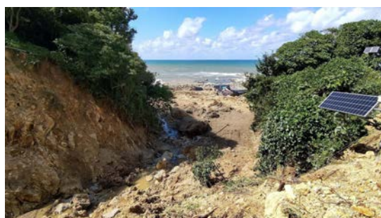
治山堰堤が施工されていた箇所（豪雨後）
