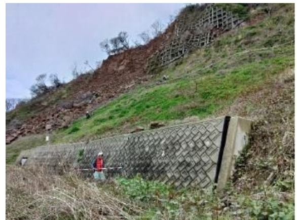
坑口上部の岩盤すべりによる法枠工の被災と土留め擁壁の押し出し
