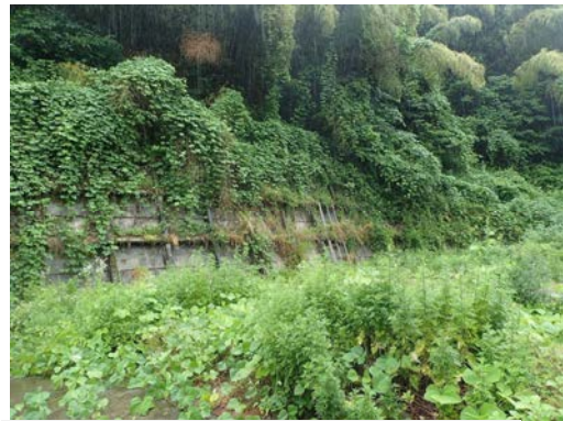
2007年の地震以降に施工されたアンカー工
