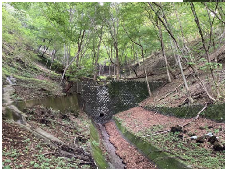
小沢内の治山ダム
