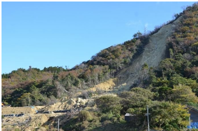
仁江集落背後の崩壊（左（東）側の崩壊） （地震時に発生・豪雨時では大きな変状は確認されていない）
