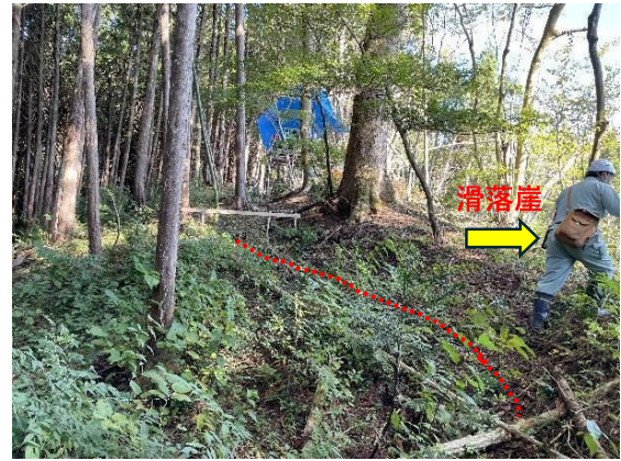
滑落崖上方斜面の尾根部：線状凹地状に亀裂（赤線）
