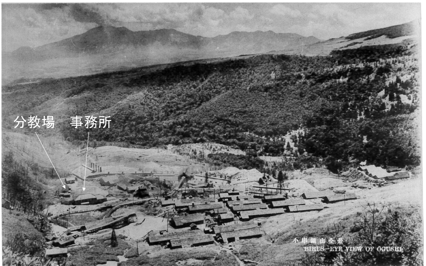
崩壊した背後斜面からみた小串鉱山
