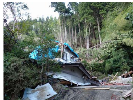
豪雨の崩壊による被災家屋
