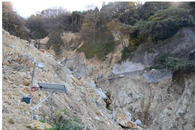
豪雨後の仁江川の荒廃状況（右（西）側の崩壊） （堆積土砂の流出・治山堰堤の破壊）
