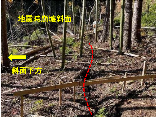
手前が対策工実施側：斜面に形成された開口亀裂
