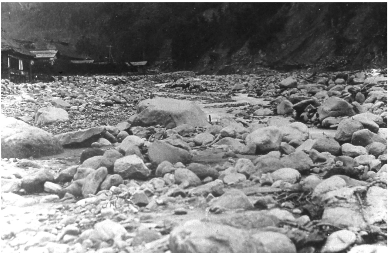
土石流により河原と化した年丸集落付近(沼尾川)
