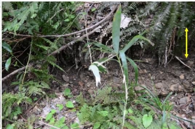
10m程度の連続性がある側部亀裂と段差 (Bブロック側部)
