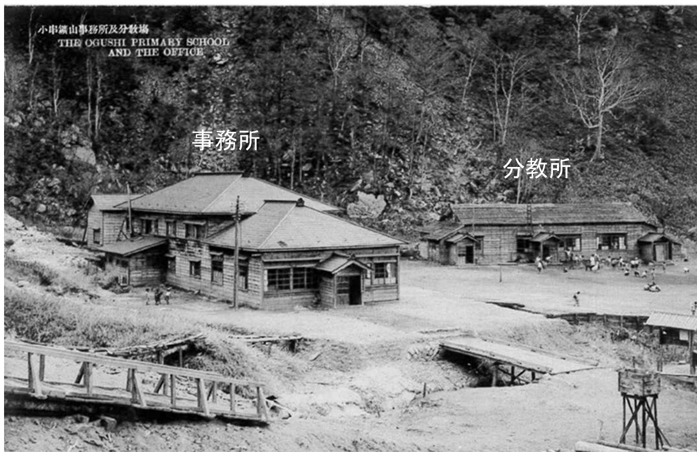
被災した小串鉱山事務所・孺恋西尋常小学校分教場
