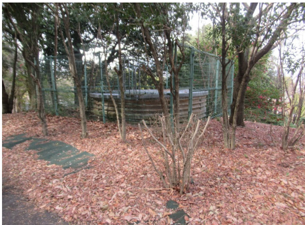
集水井工と排水トンネルの立体排水工
