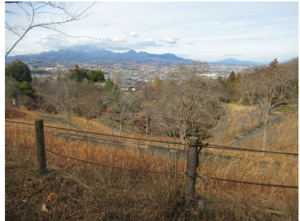
頭部より排土工施工状況と榛名山の眺望
