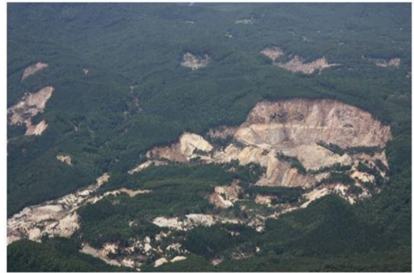
写真-2 荒砥沢地すべり全景 (2008.6 撮影)
