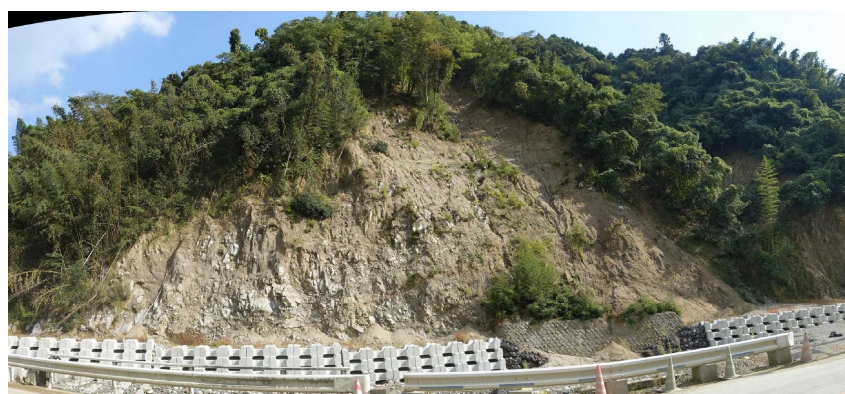
乙石川流域の崩壊地斜面（対策前）
