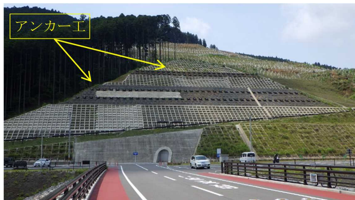
小石原川ダムダムサイト左岸法面
