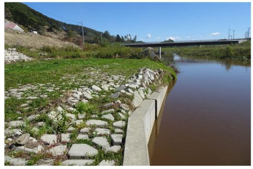
移動体自体は到達していないが護岸工が波状に変状
