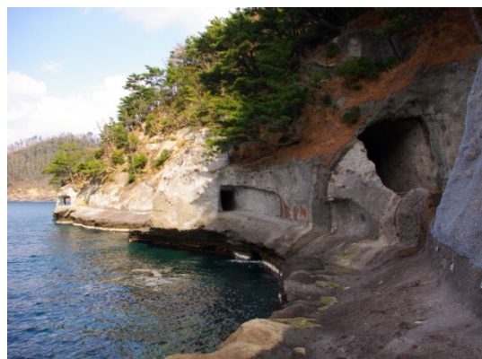
図-8 島根地質 100 選・福浦トンネル土木遺産
