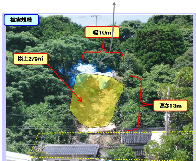
図-1 恵曇落石の崩壊状況
