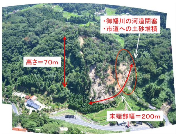
図-2 御幡川地すべり 崩壊状況
