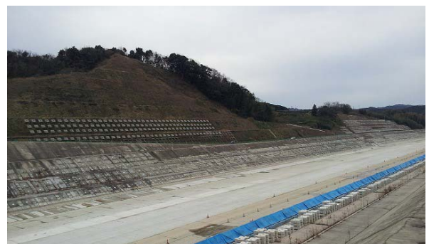
図-3 斐伊川放水路の左岸側切土斜面状況
