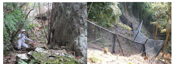
図-4 石見銀山遺跡内の浮石状況および対策
