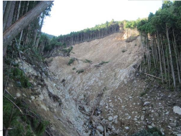
金山谷川崩壊地の状況
