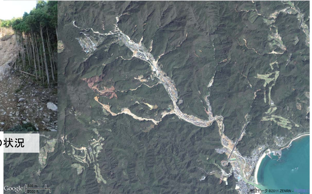
那智川の土砂移動現象発生状況
