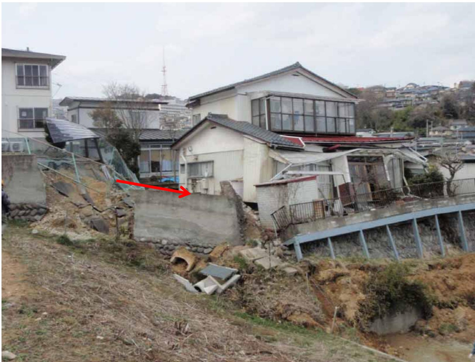
**盛土斜面の地すべり（近傍で多量の湧水が見られる）
