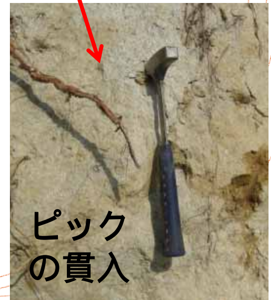
写真左上：滑落崖と平行する開口節理 山側へ75～80°で傾斜
