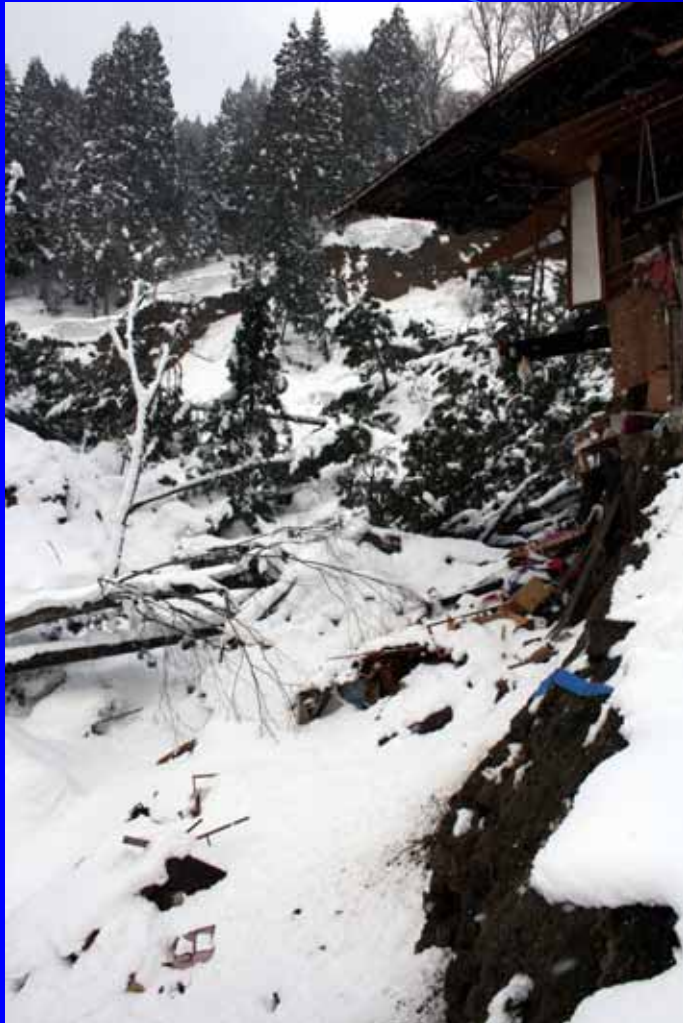
地すべりによって破壊された民家と頭部滑落崖
