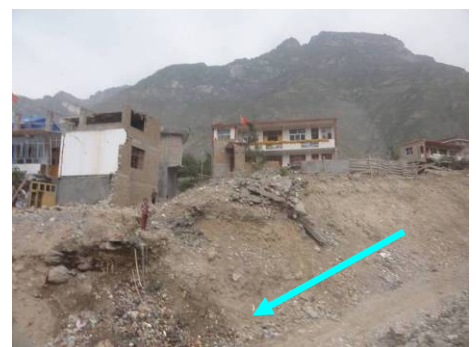
写真-8 罗家峪沟 家屋被災状況
