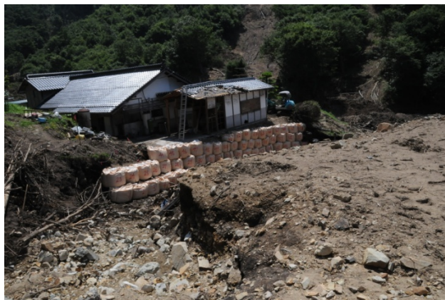
写真3 谷の出口正面にあった被災した家屋。写真右手前にあった家屋が土石流により破壊され住民1名が死亡した。左手の家屋は一部のみ損壊。
