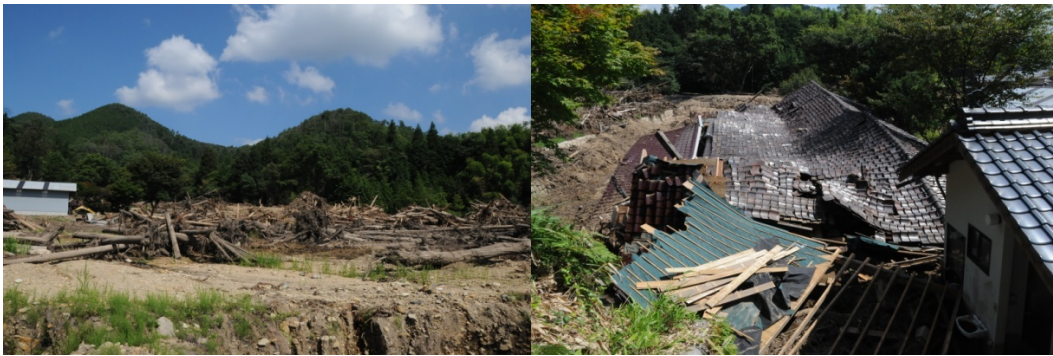
写真2 崩壊多発地区中心に近い先大戸地区の集落に堆積した流木と土砂、および破壊された家屋。
